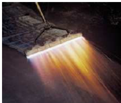
FIGURE 2.14 – Brûleur pour décapage thermique, [Courard, 2011]
