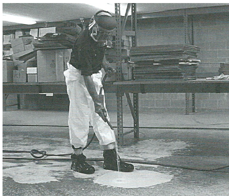
FIGURE 2.15 – Illustration d'un décapage chimique, [ICRI, 1997]
