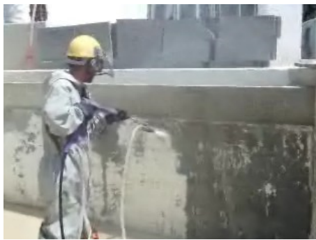
FIGURE 2.5 – Exemple d'hydrosablage ( http://www.hydrocleaning.com )
