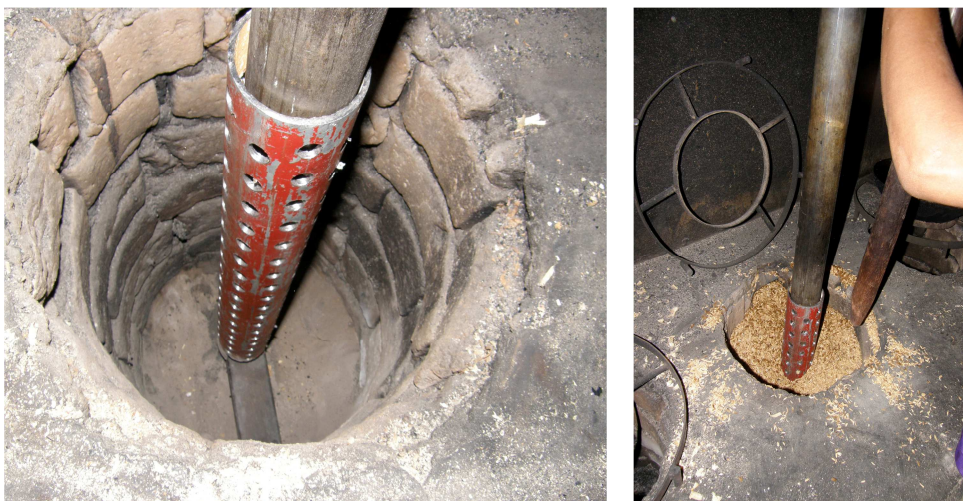
Figure 11 - Placement des profilés et compactage de la balle de riz
