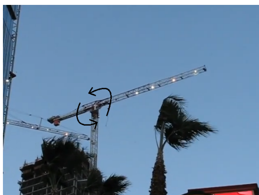
FIGURE 2.3.4 – Mouvement auto-rotatif d'une grue au centre-ville de Las Vegas [youtube.com, 2008].
