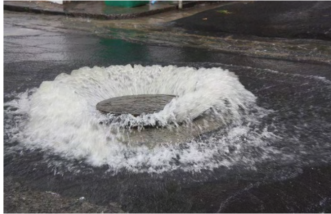
FIGURE 1.2 – Soulèvement d'une taque d'égout sous l'effet de la pression à Port-Louis, Île Maurice (inondations du 23 février 2011) [5]
