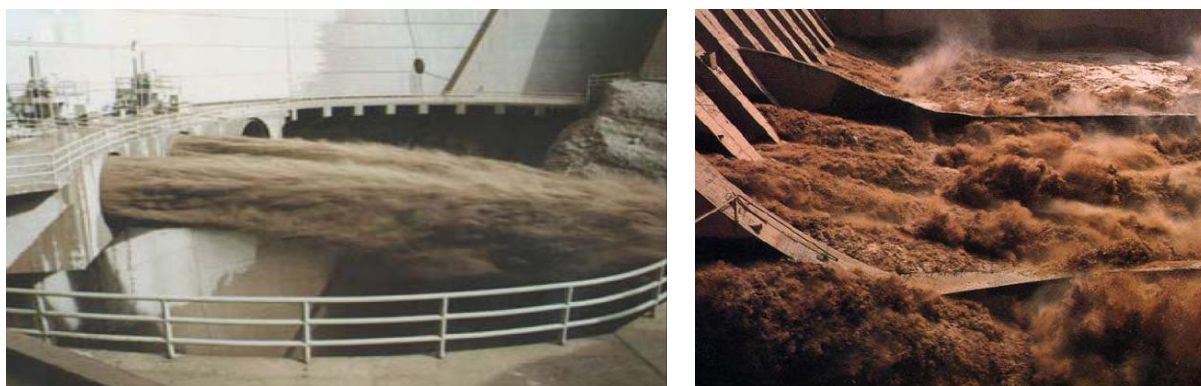
Figure 1 - Chasse hydraulique réalisée en Iran (Dez Reservoir) à gauche (Emamgholizadeh et al., 2006) et en Chine (Sanmenxia Reservoir) à droite (CIGB-ICOLD, 2009)
