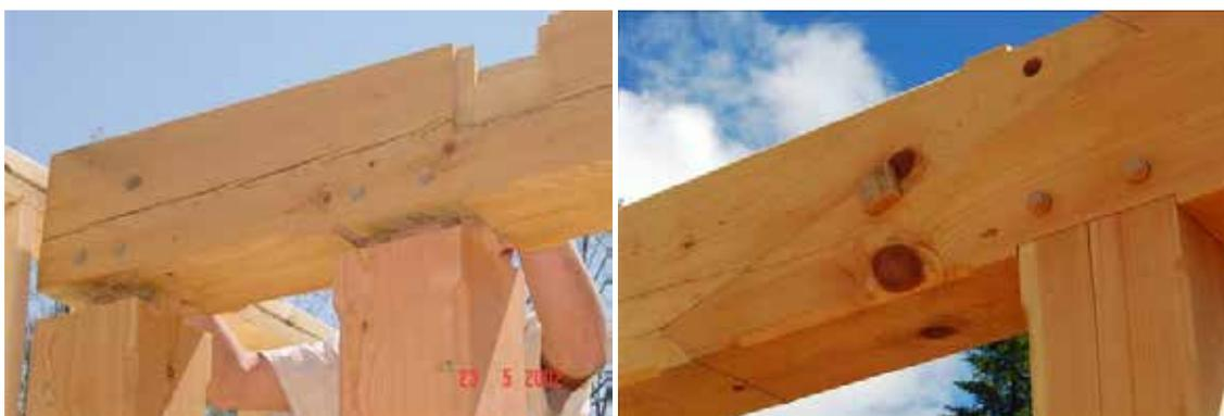
FIGURE 2.13 – EXEMPLES D'ASSEMBLAGES POUTRE-POTEAU ET POUTRE-POUTRE PAR EMBRÈVEMENT [WWW.FR.HEIRLOOMTIMBERFRAMES.COM]
