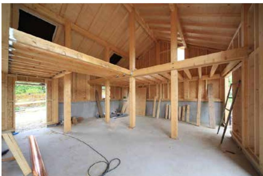
FIGURE 2.1 – EXEMPLE DE COMBINAISON ENTRE L'OSSATURE BOIS ET LE POTEAUX/POUTRES [WWW.CHARPENTE-MARTINOD.COM]
