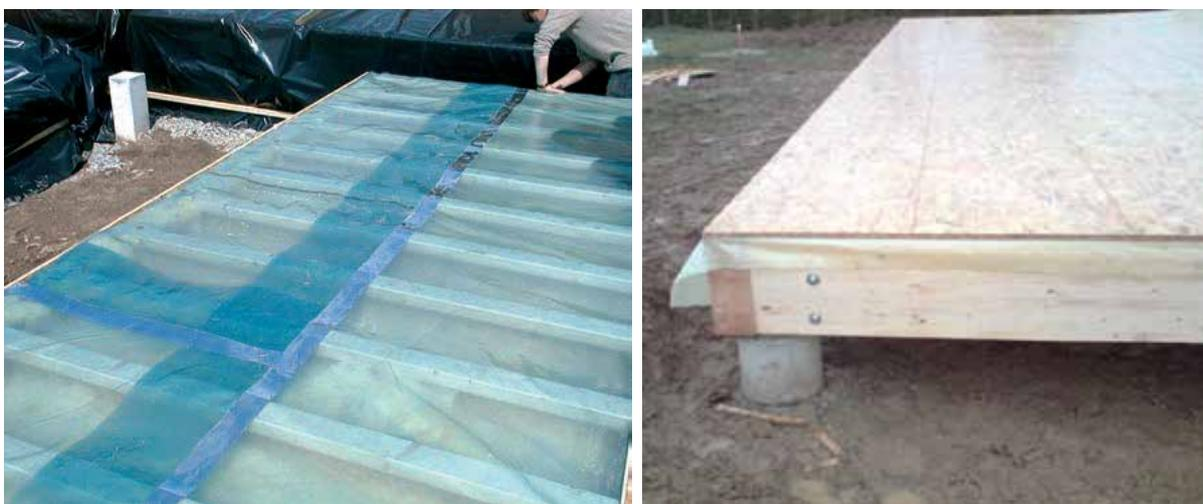
FIGURE 6.11 – MISE EN PLACE DE L'ISOLANT ENTRE LES SOLIVES, DU PARE-VAPEUR, ET DES PANNEAUX D'OSB [2],
