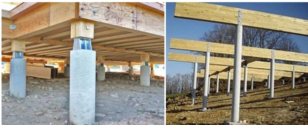
FIGURE 1.4 – FONDATIONS DE TYPE « PLOTS EN BÉTON » (À GAUCHE) OU « MICROPIEUX » (À DROITE)
