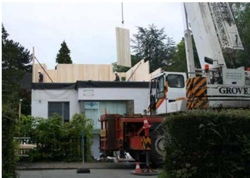
FIGURE 7.4 – SURÉLÉVATION D'UNE MAISON EN PANNEAUX MASSIFS CLT [24]
