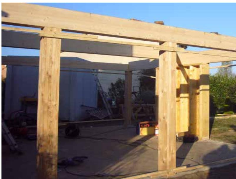
FIGURE 7.3 – EXTENSION D'UNE MAISON EN POTEAUX/POUTRES [WWW.CHARPENTES-GASPIN.COM]
