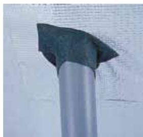
FIGURE 6.26 – SCOTCH EN ALUMINIUM PERMETTANT DE CONSERVER L'ÉTANCHÉITÉ À L'AIR [2]
