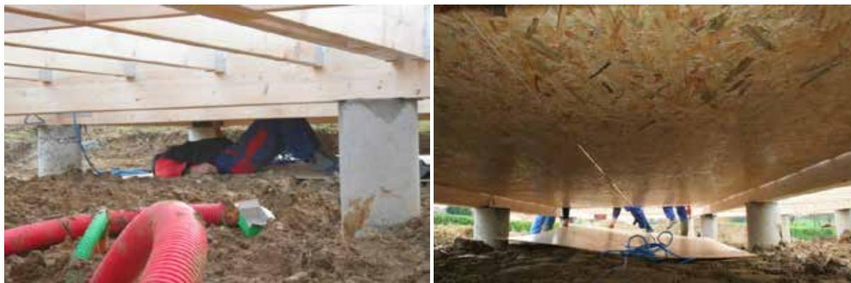
FIGURE 6.10 – MISE EN PLACE DES PANNEAUX D'OSB SUR LA PARTIE INFÉRIEURE DES SOLIVES
