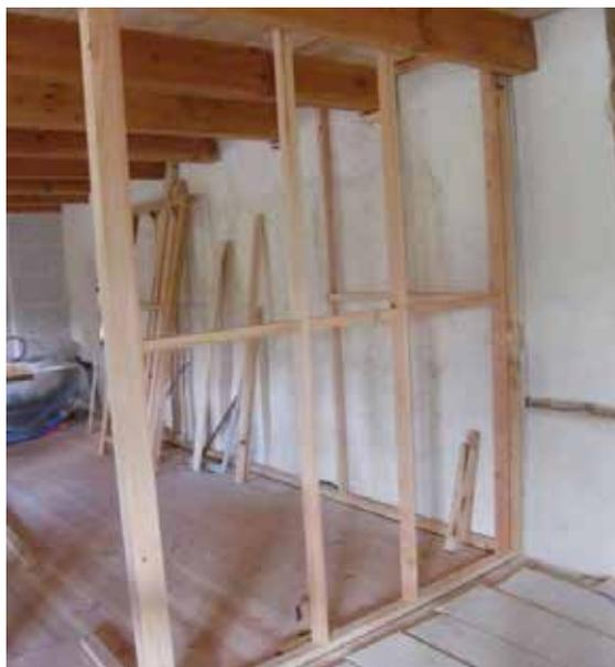
FIGURE 7.13 – FIXATION DE MONTANTS ET DE TRAVERSES FORMANT L'OSSATURE BOIS D'UNE CLOISON
