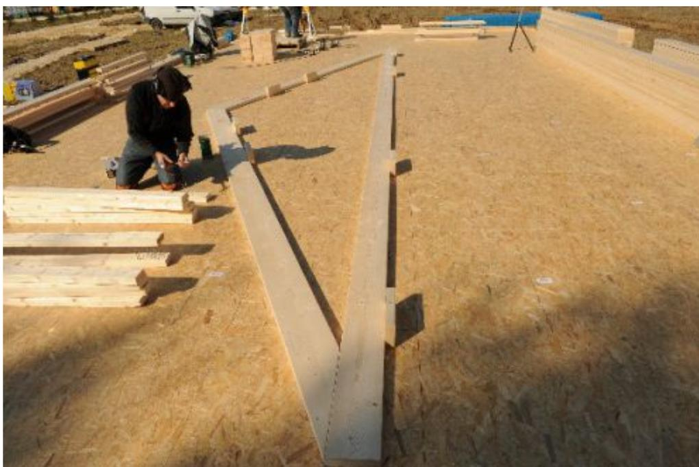
FIGURE 6.21 – PRÉFABRICATION DES FERMES DE TOITURE SUR LE PLANCHER FINI DU REZ-DE-CHAUSSÉE [10]
