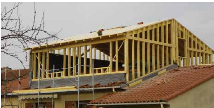
FIGURE 7.12 – SURÉLÉVATION EN OSSATURE BOIS [WWW.LOSSATUREBOIS.FILES.WORDPRESS.COM]
