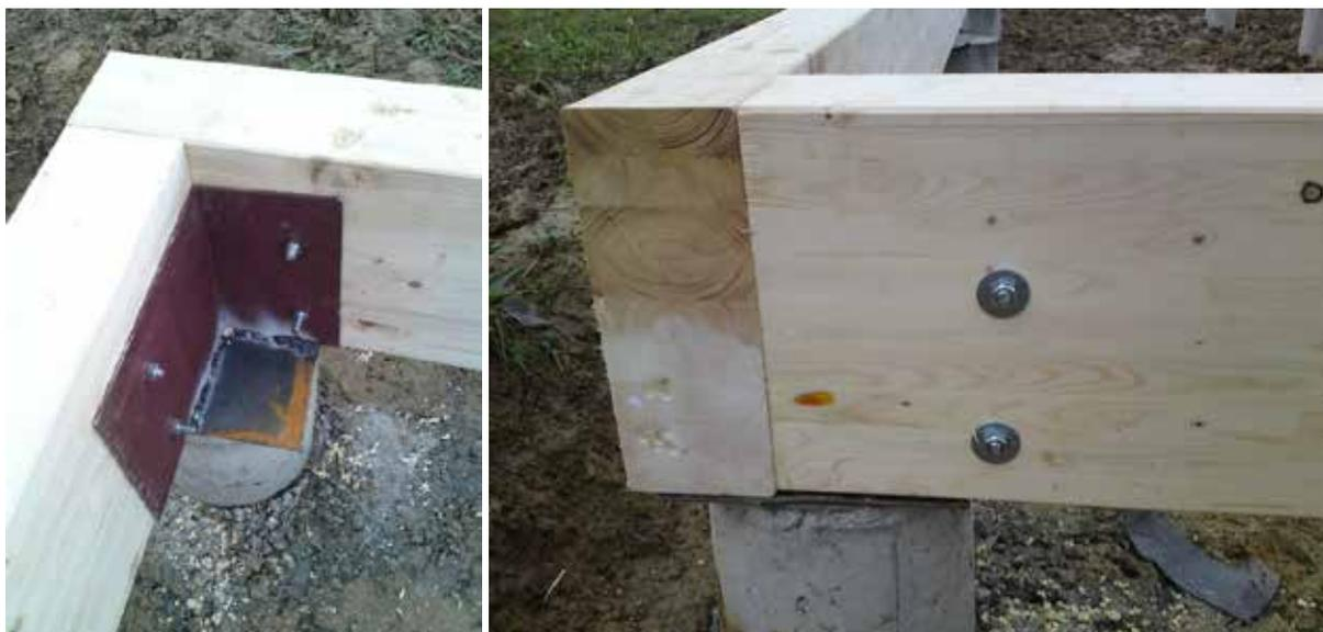
FIGURE 6.8 – ASSEMBLAGE PAR PLATS SOUDÉS ET BOULONS SUR UN PLOT EN BÉTON
