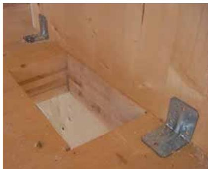
FIGURE 2.29 – ÉQUERRE MÉTALLIQUE POUR L'ASSEMBLAGE MUR-PLANCHER [FPIINNOVATIONS]
