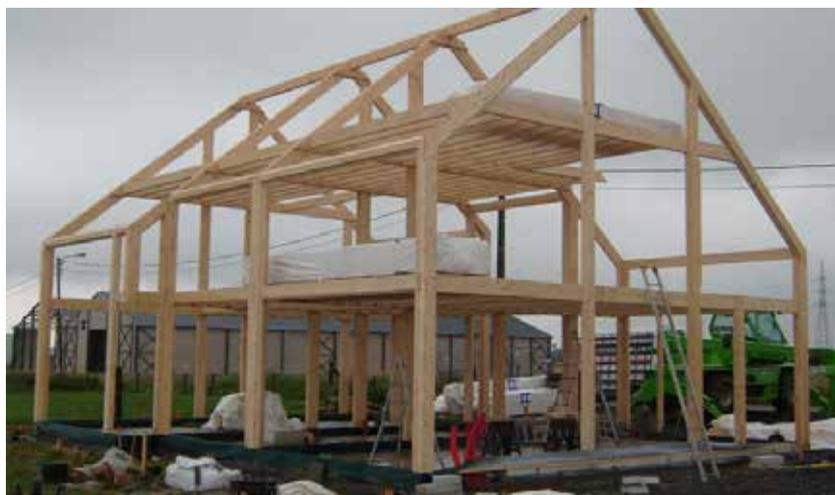
FIGURE 2.11 – VUE DES POTEAUX ET DES POUTRES D'UNE STRUCTURE POTEAUX/POUTRES [WWW.CRE-HABITAT.BE]
