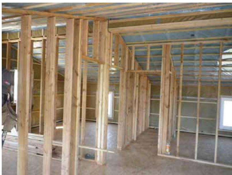
FIGURE 7.5 – CLOISONS EN OSSATURE BOIS [WWW.LEREDUBOIS.COM]
