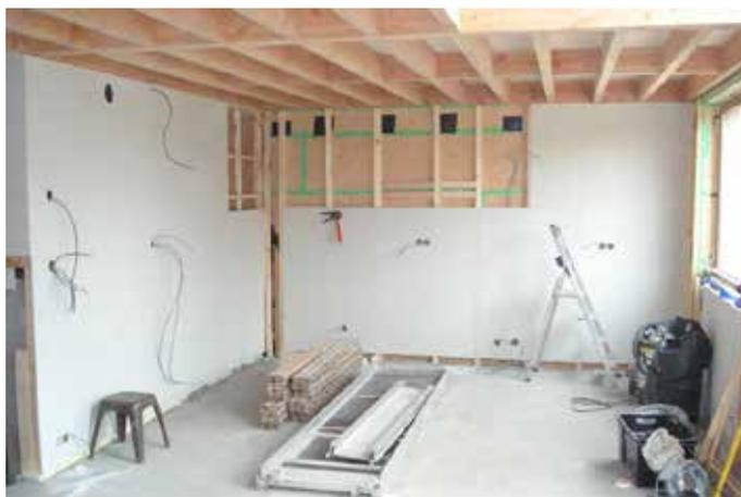
FIGURE 6.29 – PANNEAUX EN FIBRES DE PLÂTRE [WWW.CONSTRUCTION-MAISON-OSSATURE-BOIS.INFO]
