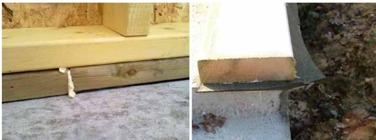
FIGURE 6.6 – VUE DE LA LISSE BASSE D'ASSISE (À GAUCHE) ET DU FEUTRE BITUMINEUX (À DROITE) [WWW.INEKO-BARDAGE.FR, WWW.A398.IDATA.OVER-BLOG.COM]
