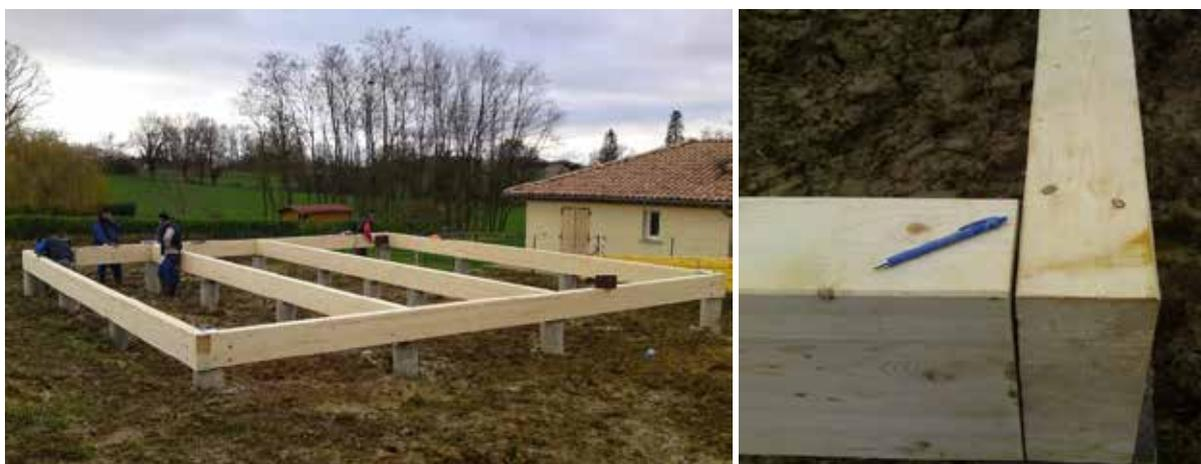
FIGURE 6.7 – MISE EN PLACE DE LA POUTRE « CEINTURE » [WWW.NOTREMOB01.CANALBLOG.COM]
