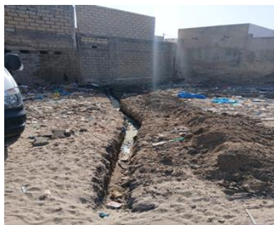
Figure 15 : Caniveau creusé artisanalement
