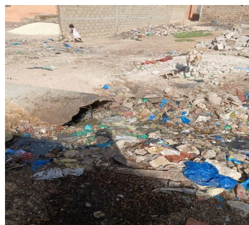
b) Canal d'évacuation bouché
