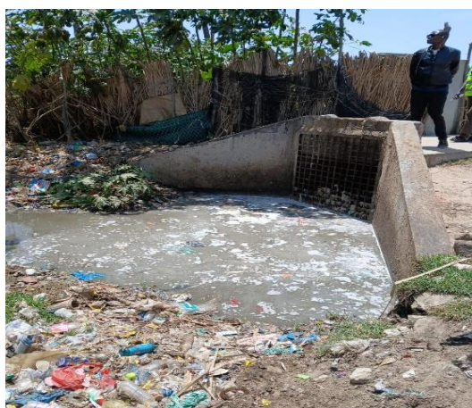
a) Obstruction d'un drain
