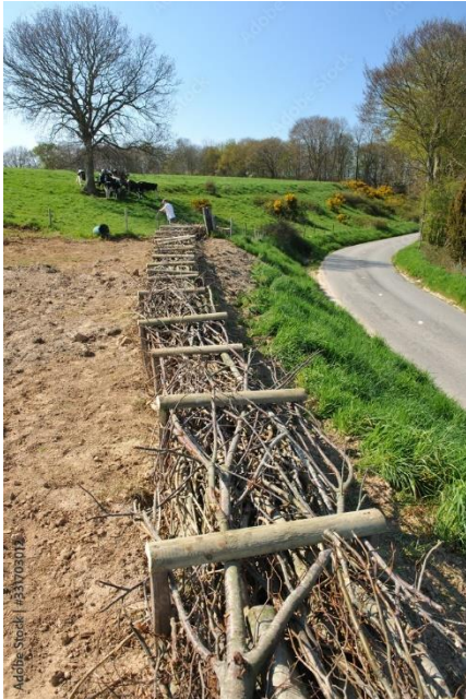
Figure 16: Lutte contre l'érosion des sols. Construction d'une fascine dans un champ de blé afin d'éviter les coulées de boues sur la route Menos de S. Leitenberger. Sourc: stock.adobe.com
