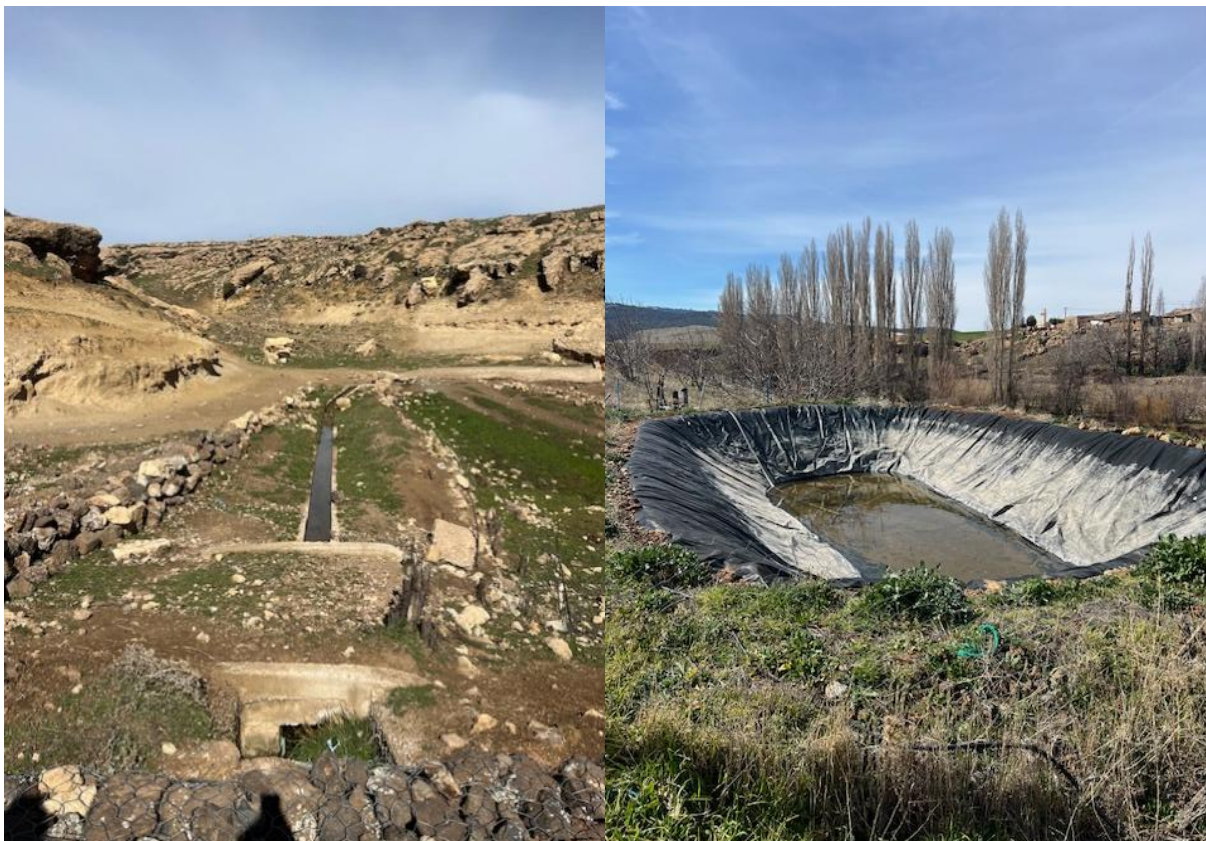
Figure 45 : Séguias avec la présence d'une source non visible en amont et bassin de stockage
