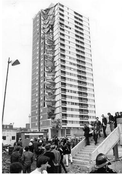
Figure 1 : Effondrement partiel du Ronan Point (image provenant de http://en.wikipedia.org/wiki/Ronan_Point )
