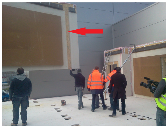
FIGURE 6.43 – Discontinuité dans le panneau de VIDIWALL du pignon 3
