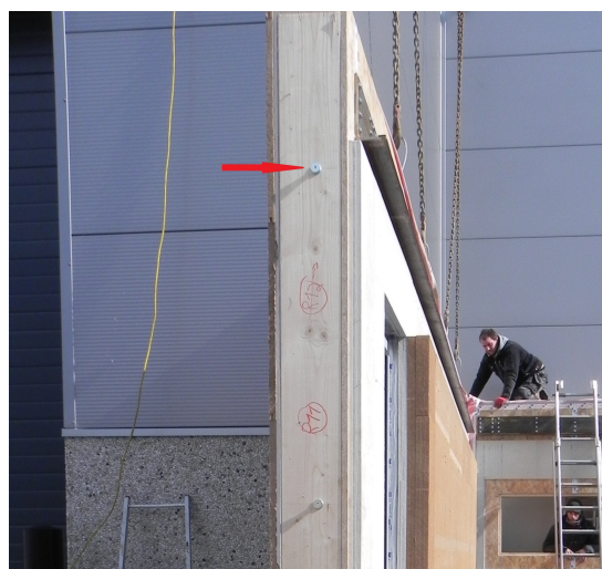
FIGURE 4.10 – Partie mâle KNAPP
