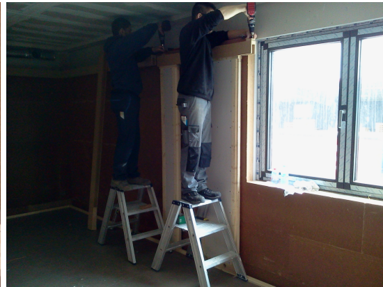
FIGURE 6.50 – Fixations des cloisons complexes et non standards - perte de temps
