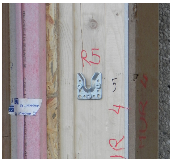
FIGURE 4.9 – Partie femelle KNAPP
