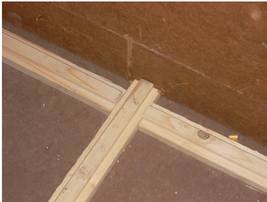
FIGURE 6.49 – Sabots de support des cloisons collés au sol - repères difficiles
