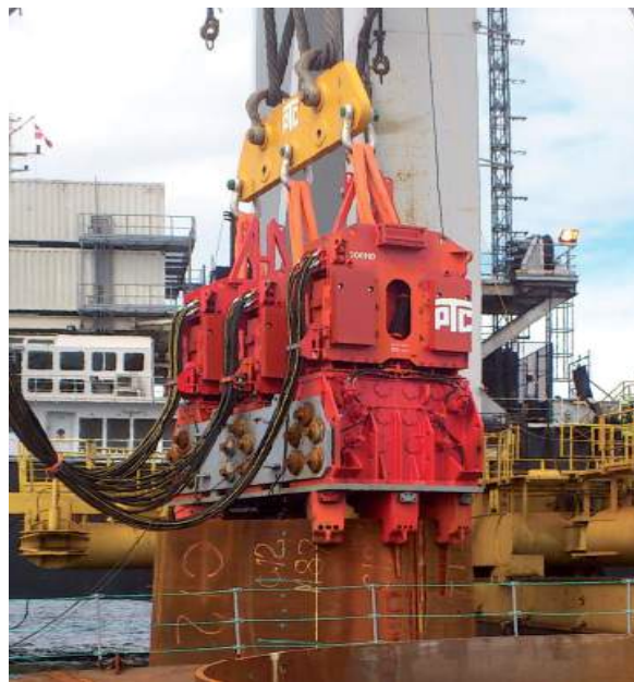
Figure 6 - Mono-pieu battu par marteau vibrant 5
