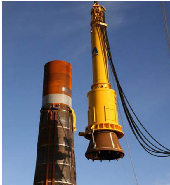
Figure 5 - Mono-pieu battu par marteau hydraulique 4
