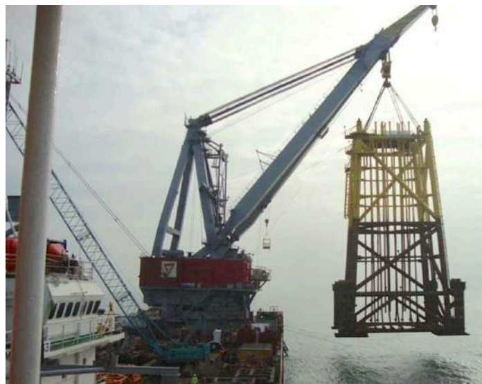
Figure 10 - Transport et installation de fondation de type jacket 9
