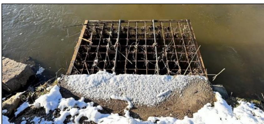
Figure 17. Dispositif de protection de pertuis installé au niveau du barrage de la route du chalet (10/01/2025)
