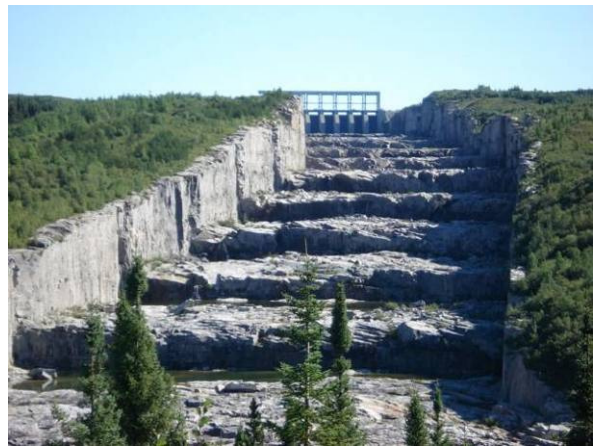
Figure 7 : Marches de l'évacuateur du barrage de La Grande, Québec, Canada [8]
