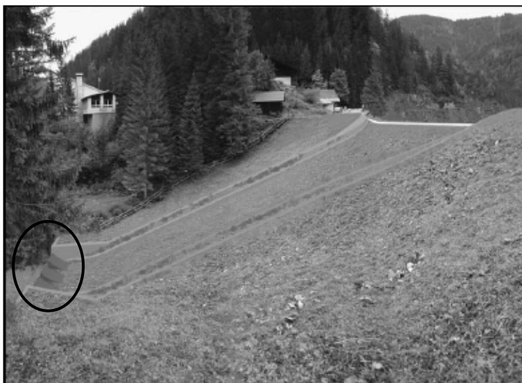
Figure 15 : Evacuateur de crue et indentations du barrage de Gosau, Oberösterreich, Autriche [X]
