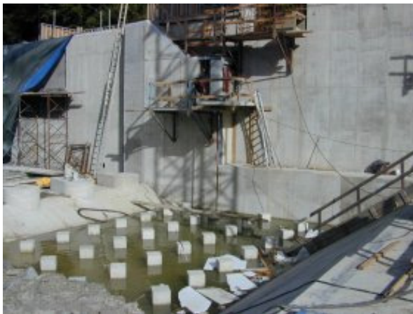
Figure 6 : Macro-rugosité à Hastière, Belgique [1]
