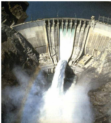
Figure 10 : Saut de ski et indentations en bout de pente
