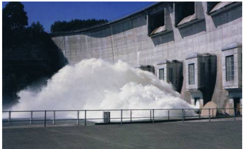
Figure 11 : Diffuseur en vanne de fond, barrage de Schiffenen, Fribourg, Suisse [7]
