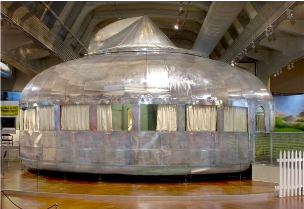
(Image 26) Prototype de la Dymaxion House (1946) conçu par Buckminster Fuller, exposé au Henry Ford Museum, Dearborn, Michigan. Assemblée à partir d’aluminium aéronautique, cette maison démontable, préfabriquée et transportable incarne la vision d’un habitat léger et industrialisé (Henry Ford Museum, s.d.).
