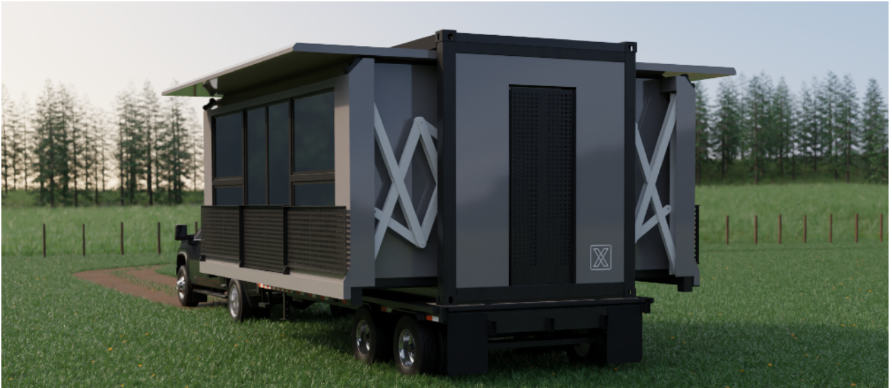
(Image 18) Module déployable TF-20, TenFold Engineering, début 2020. Structure à châssis conteneur s'ouvrant en 64m 2 via visseuse en 10minutes, sans fondation. (Ten Fold Engineering, 2024)
