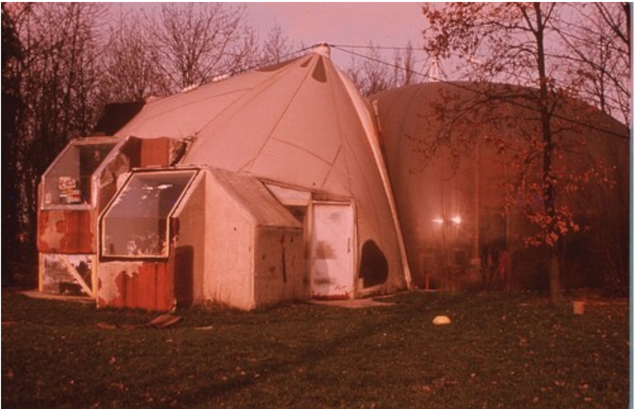
(Image 24) Symbiose & Symbicle (Balloon Home, 1973–1982) de Lode Janssens à Humbeek. Projet expérimental composé d'un dôme pneumatique en PVC et de modules habitables sur pilotis, conçu comme une « thérapie pour vivre avec la nature » et emblème d'une architecture légère et réversible (CIVA, s.d.).
