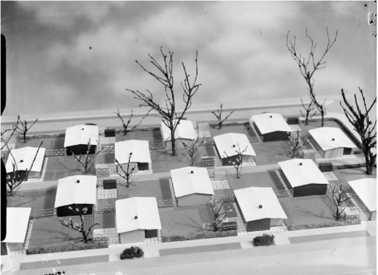
(Image 12) Modèle de lotissement de logements préfabriqués, Royaume-Uni, 1944. Exemple de planification d'après-guerre avec des maisons temporaires assemblées rapidement pour reloger les sinistrés. (Imperial War Museums, 1944)
