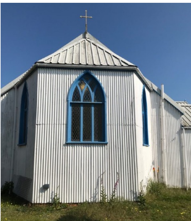
(Image 8) Tin Tabernacle, Hythe, Kent, Angleterre. Chapelle préfabriquée en tôle ondulée, commandée à Croydon et assemblée en 1893 pour desservir une communauté ouvrière. (The Tin Tabernacle Hythe, s.d.)
