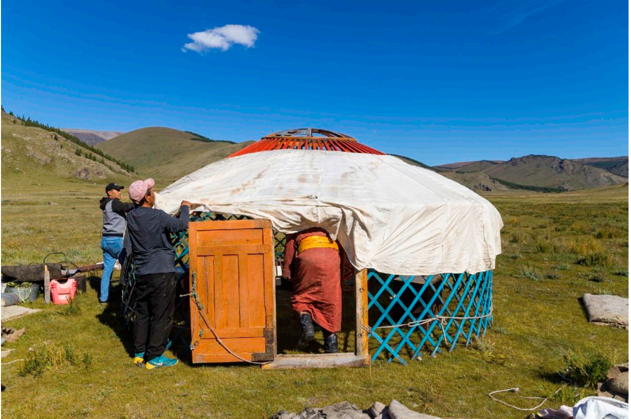
(Image 2) Montage d'une yourte (ger) traditionnelle dans les steppes mongoles, habitat nomade emblématique des pasteurs d'Asie centrale. La structure en treillis bois, les perches rayonnantes et la couverture en feutre assurent légèreté et efficacité thermique. Photographie publiée sur le site Rafi Voyage (2024).
