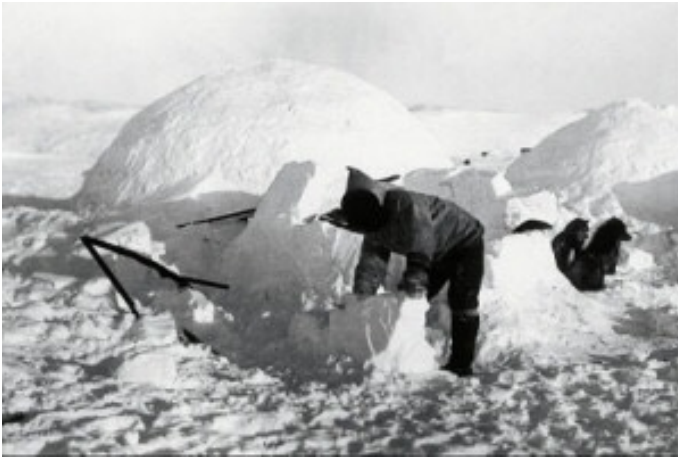
(Image 6) Construction d'un igloo inuit, abri en blocs de neige compactée offrant une isolation thermique optimale dans les climats arctiques. Photographie publiée sur le site fiabitat.com (s.d.).
