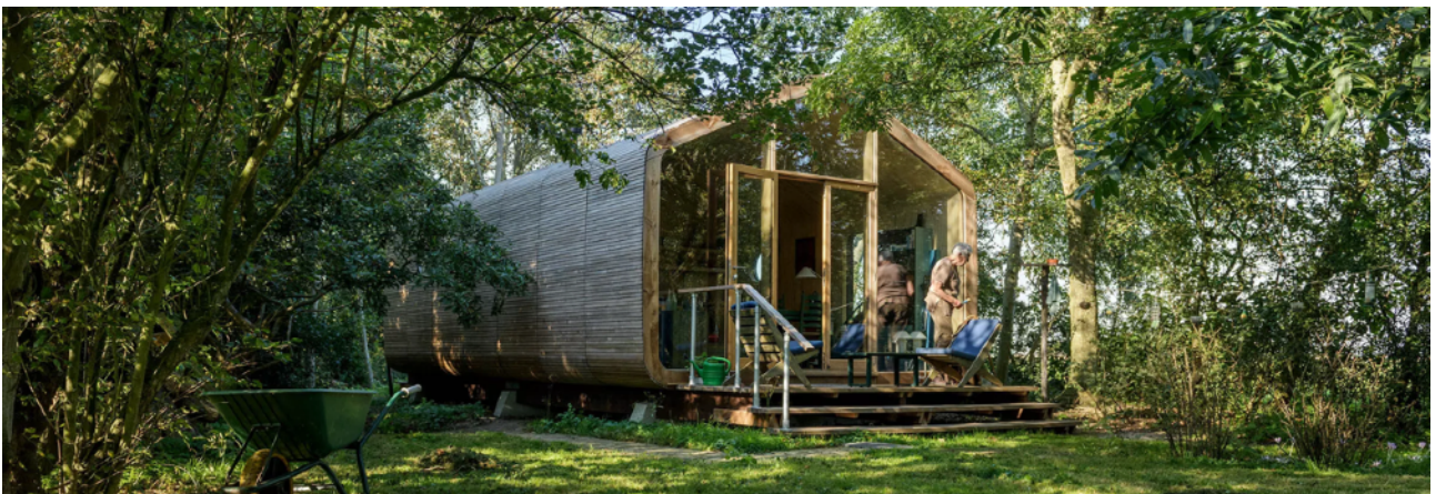
(Image 19) Wikkellhouse, Hollande, années 2020. Module enroulé de 600kg, assemblable en une journée sans fondation, reprenant le principe alimentaire des kits plats. (Fiction Factory, 2024)
