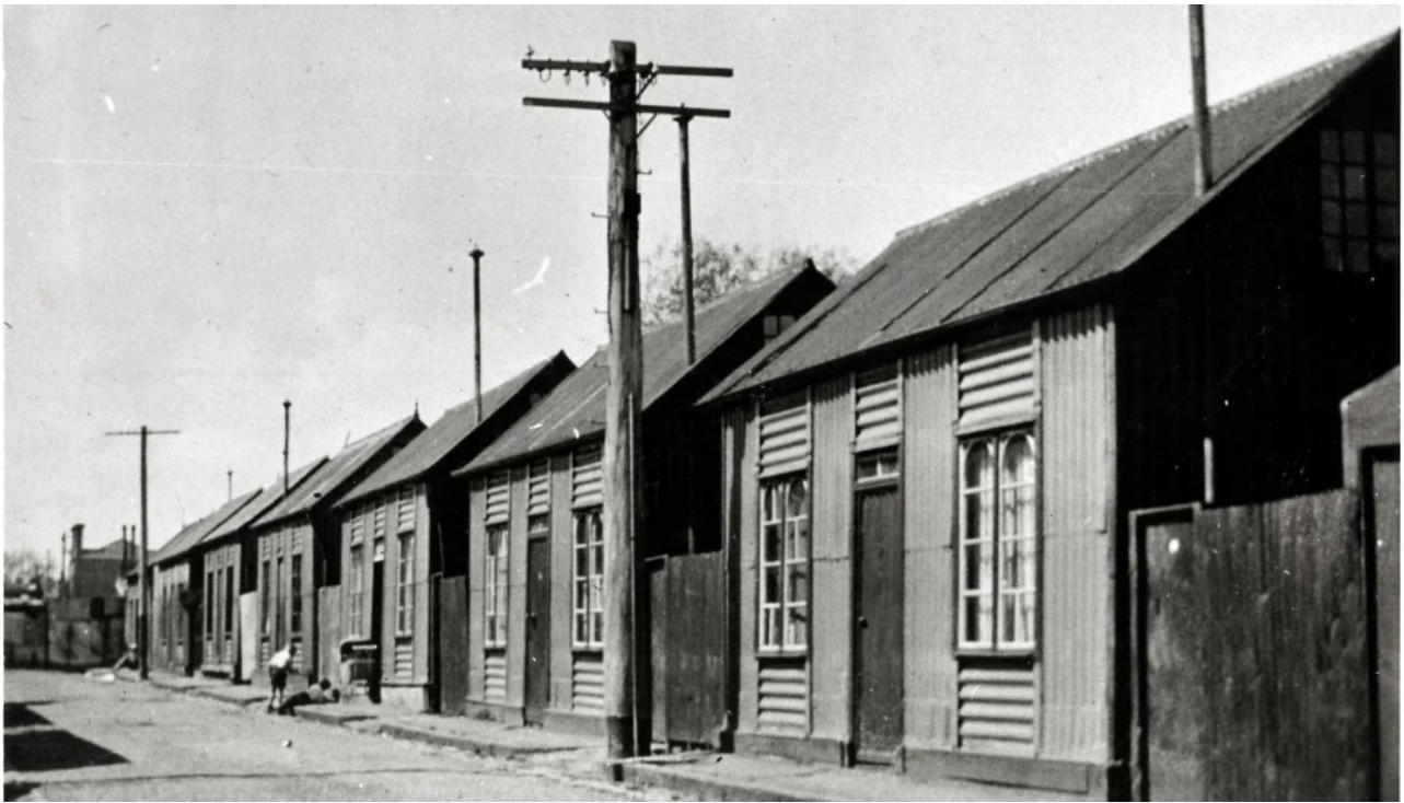
(Image 7) Portable Iron House, South Melbourne, Australie. Exemple de bâtiment préfabriqué en tôle ondulée, expédié d'Angleterre pour la ruée vers l'or. (National Trust Australia, s.d.)
