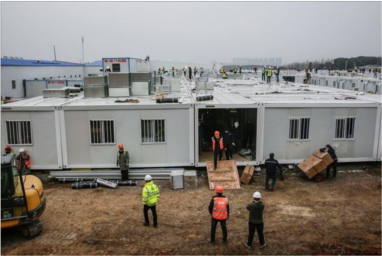
(Image 37) Construction accélérée d'un hôpital temporaire modulaire à Wuhan (Chine), monté en dix jours pour accueillir des patients atteints du coronavirus, démontrant la capacité d'intervention rapide des structures légères en situation de crise (Anadolu Agency, 2020).
