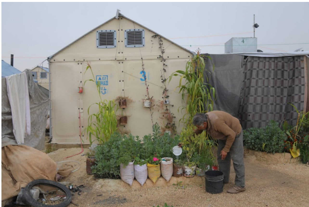
(Image 36) Modules d'urgence Better Shelter ® utilisés dans un camp humanitaire pour reloger des sinistrés ou des réfugiés. Ces unités standardisées et démontables permettent un hébergement digne et rapide en cas de crise (Better Shelter, 2023).
