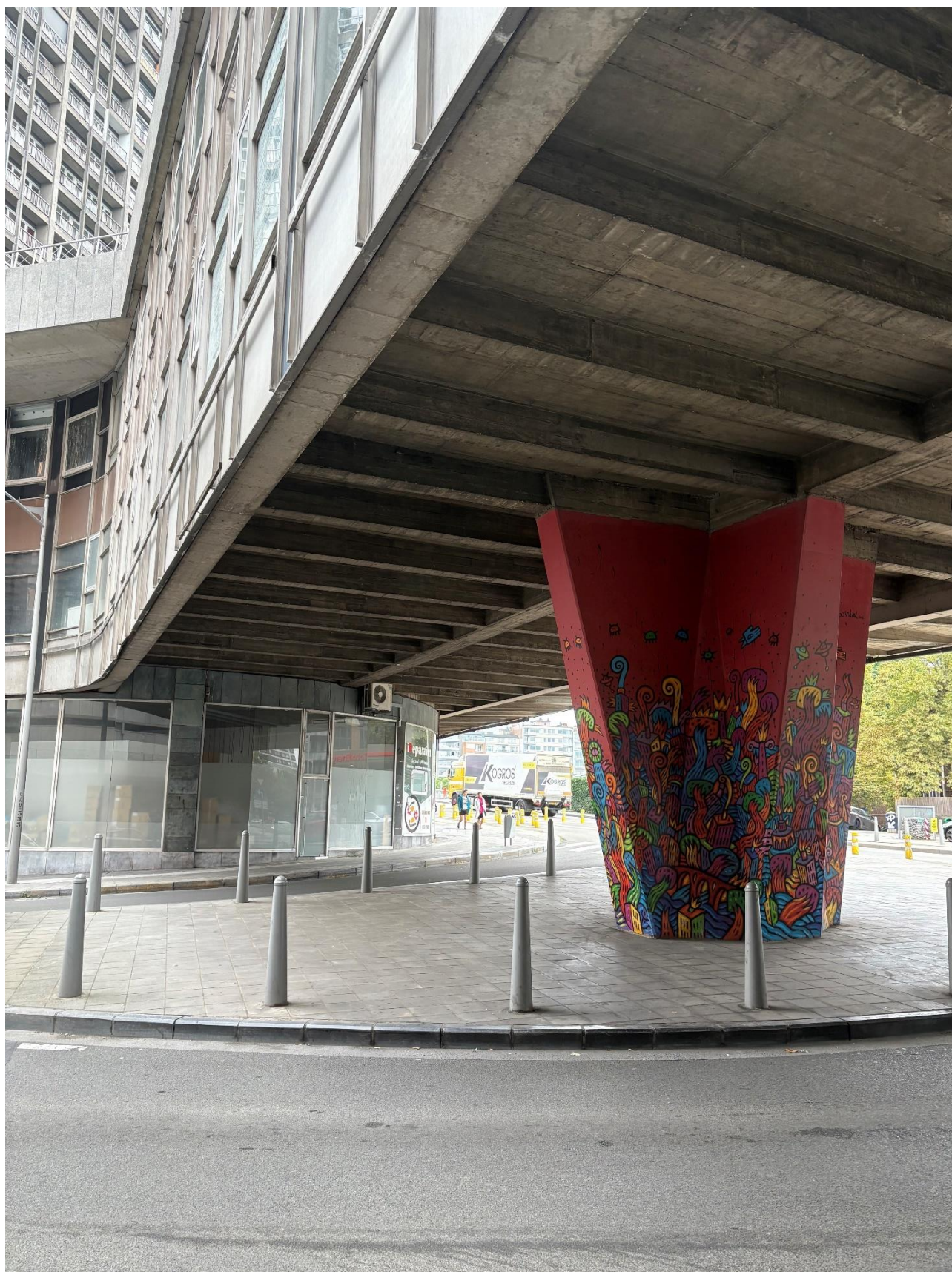
Figure 54 : La colonne cruciforme qui soutient la structure du bâtiment-pont - photo personnelle
