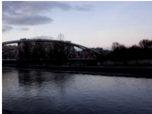
FIG. 41: VUE SUR LE PONT DU RER
