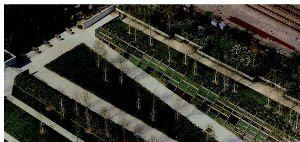
FIG. 149: VUE AÉRIENNE DU JARDIN DES CASCADES VERTES
