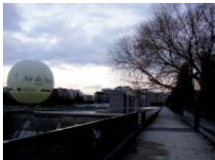
FIG. 37: CHEMIN LE LONG DU CANAL D'EAU - PASSERELLE POUR Y ACCÉDER
