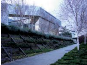
FIG. 32: TALUS PLANTÉS PÉRIPHÉRIQUES ET BÂTIMENTS VITRÉS EN ARRIÈRE PLAN
