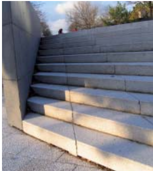
Fig. 87: ESCALIER EN DIAGONALE
