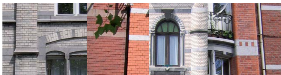
FIG 203-204: TEXTURES DES FAÇADES
