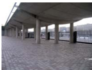
FIG. 126: SOUS LE PONT DU RER
