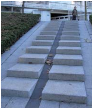
FIG. 81: ESCALIER EN PENTE DOUCE
