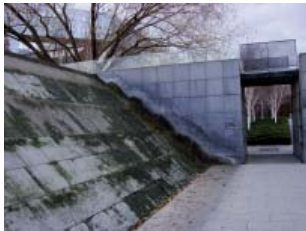
FIG. 29 : PAROI DE GAUCHE
