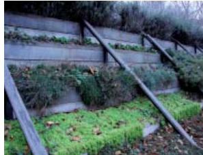
FIG. 33: VÉGÉTATION DES TALUS
