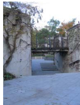
FIG. 72: CHEMIN SOUS LA PASSERELLE
