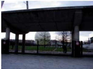
FIG. 25 : ENTRÉE SOUS PONT DU RER
