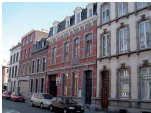
Façade avant après rénovation.
