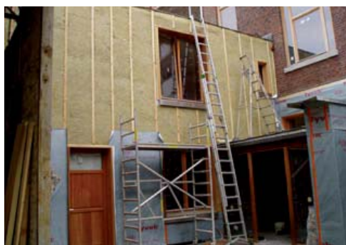
Isolation par l'extérieur et étanchéité de l'annexe.
