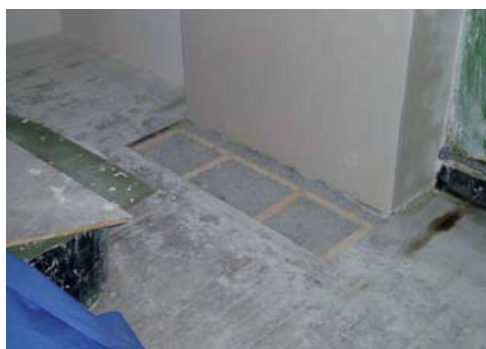
Isolation des planchers intermédiaires en cellulose.
