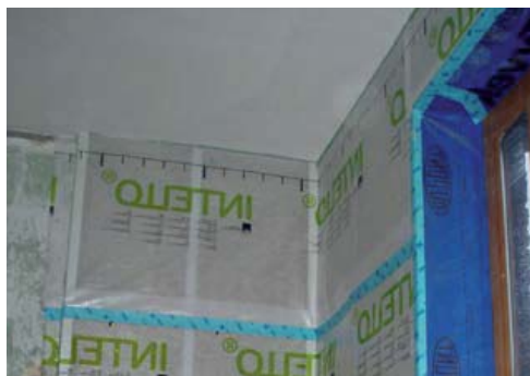
Freine-vapeur et étanchéité à l'air.
