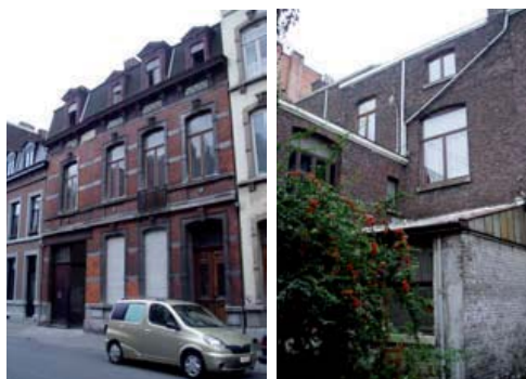
Façade avant et annexe avant rénovation.
