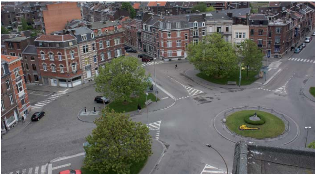
FIGURE 16: Place du Congrès (vue depuis le toit de l'immeuble d'appartements)
