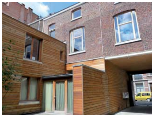
Façade arrière et annexe après rénovation.
