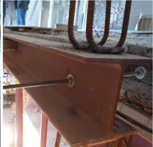
Photo 48 - Ancrage de la façade à rue dans la dalle (Source : Bureau A2M, 2011)
