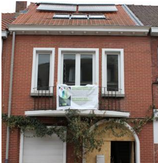
Photo 13 – Façade côté rue avant rénovation (Source : Alexandre O., 2011)
