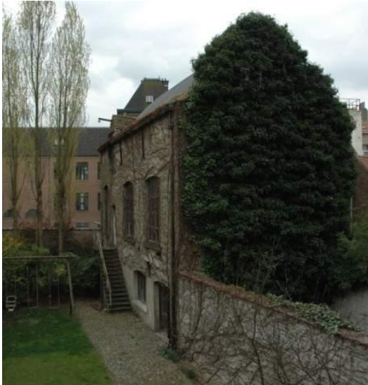
Figure 45 – Vue générale du bâtiment (Source : IBGE, 2007)
