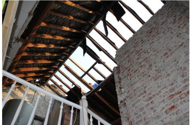
Photo 12 – Chevrons de la toiture (Source : Alexandre O., 2011)
