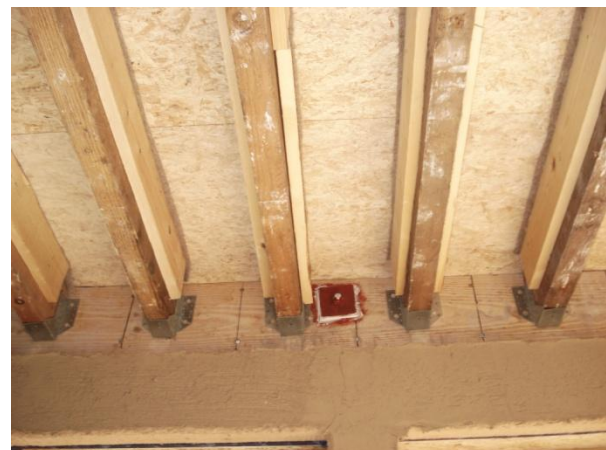
Photo 29 - Epinglage intérieur de la façade avant
