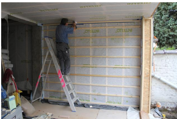
Photo 34 - Pose de l'ossature, de la membrane et du lattage (Source : Alexandre O., 2011)
