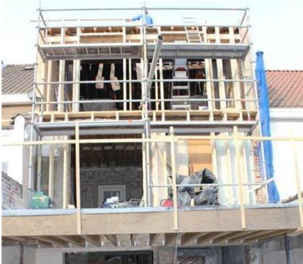
Photo 21 - Ossature de la façade côté jardin (Source : Alexandre O., 2011)
