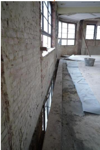
Photo 49 - Remplissage de l'encoche par du béton (Source : Bureau A2M, 2011)
