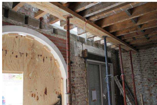
Photo 23 - Découpe des têtes des solives (Source : Alexandre O., 2011)
