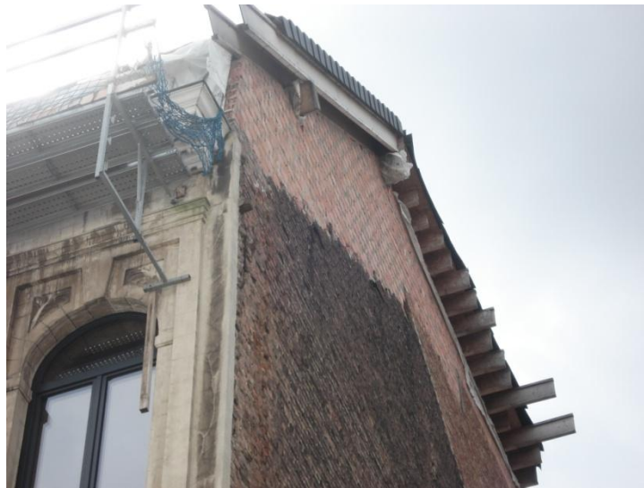
Photo 42 - Mise en place des deux poutres FJI
