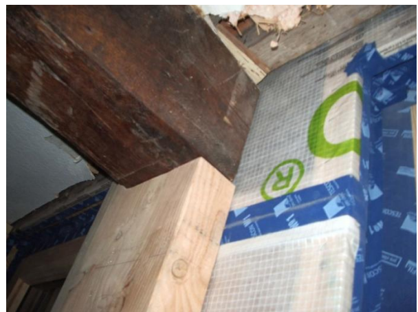
Photo 6 – Mise en place des colonnes sous les poutres coupées (Source : Bureau FHW, 2007)
