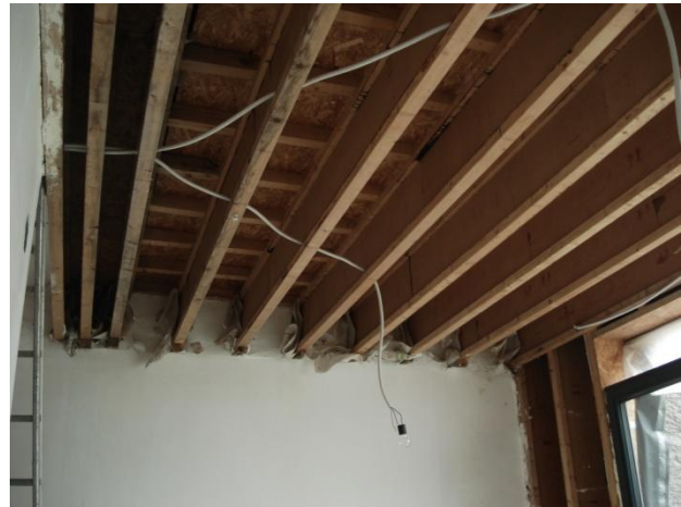
Photo 43 – Poutres FJI d'une toiture plate
