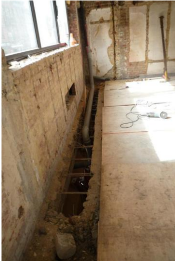
Photo 46 - Découpe de la dalle en béton (Source : Bureau A2M, 2011)
