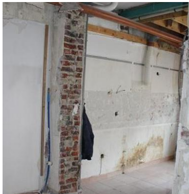
Photo 9 – Paroi en maçonnerie pleine (Source : Alexandre O., 2011)
