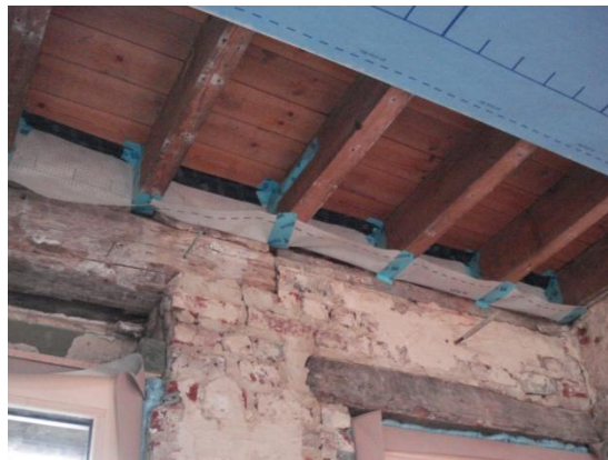
Photo 53 - Membrane d'étanchéité à l'air autour des gîtes, projet en cours de rénovation à Auderghem
