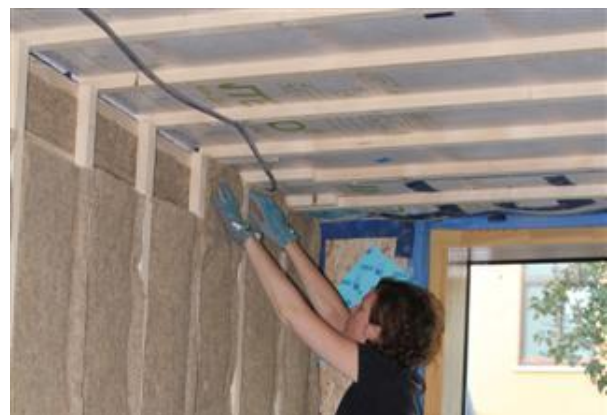
Photo 35 - Chanvre posé dans lattage et contre-lattage (Source : Alexandre O., 2011)
