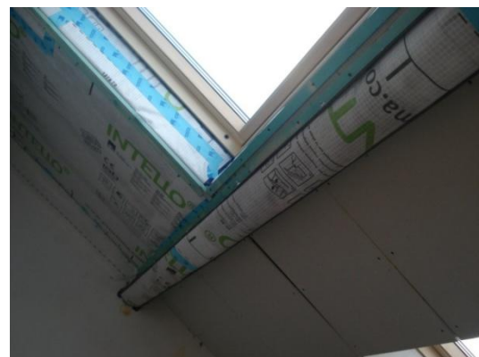
Photo 52 - Renforcement de la toiture
