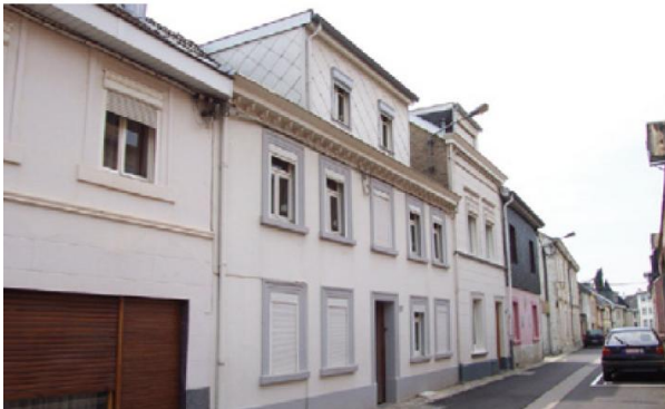
Photo 3 - Façade côté rue avant rénovation (Source : Bureau FHW, 2007)
