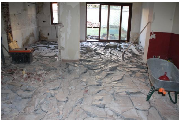
Photo 15 – Démolition du carrelage stabilisé (Source : Alexandre O., 2011)
