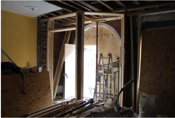
Photo 25 - Ossature en FJI du porche d'entrée (Source : Alexandre O., 2011)
