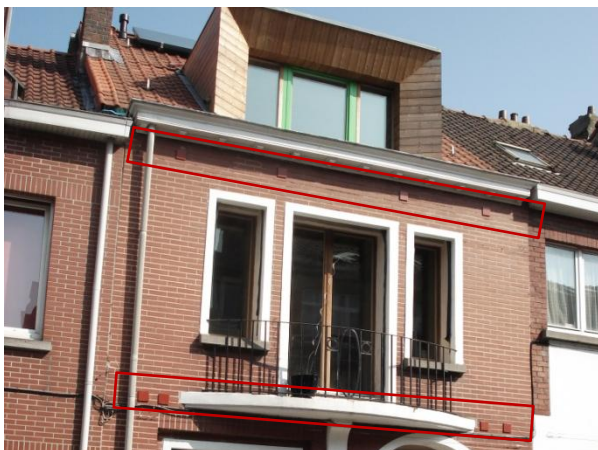
Photo 28 - Epinglage extérieur de la façade avant
