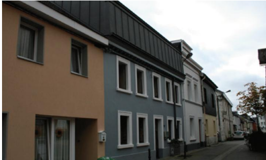
Photo 1 – Façade côté rue après rénovation
