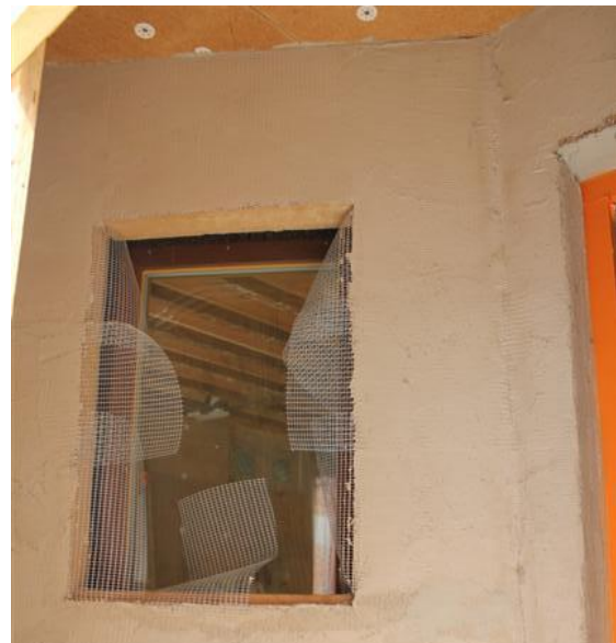
Photo 33 - Enduit à l'argile des murs intérieurs
