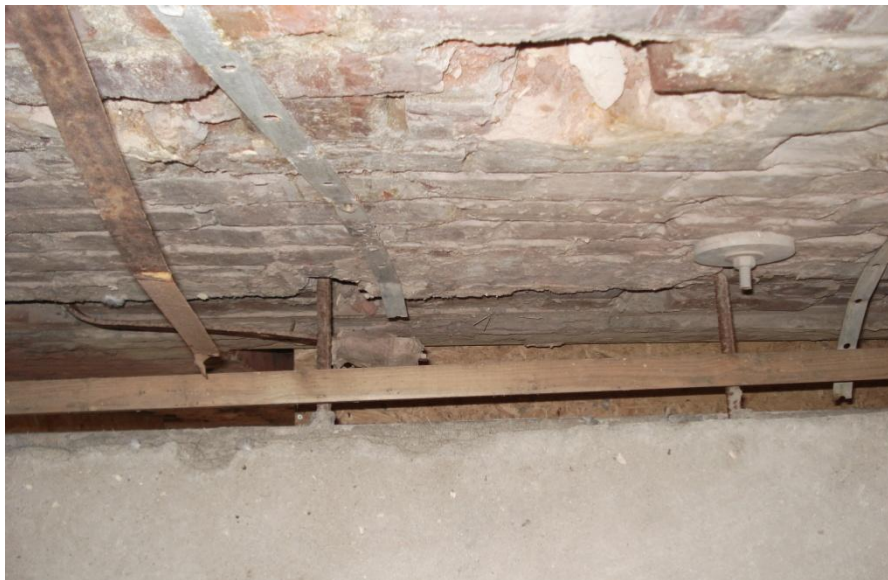
Photo 38 – Ancrage de la façade dans le plancher semi-préfabriqué
