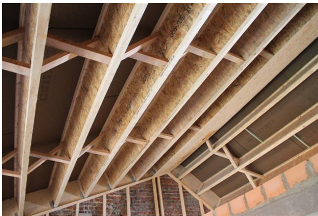
Photo 30 - Structure de la nouvelle charpente (Source : Alexandre O., 2011)
