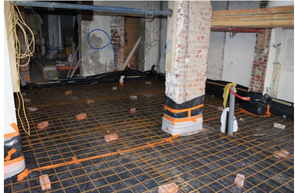
Photo 17 – Pose d'une étanchéité et des armatures (Source : Alexandre O., 2011)
