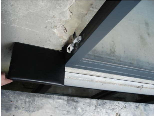
Photo 40 - Cornière inférieure et ancrage métallique du châssis
