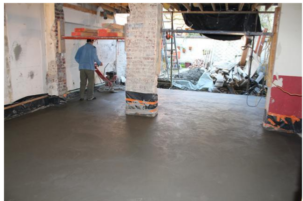
Photo 18 – Dalle de béton (Source : Alexandre O., 2011)
