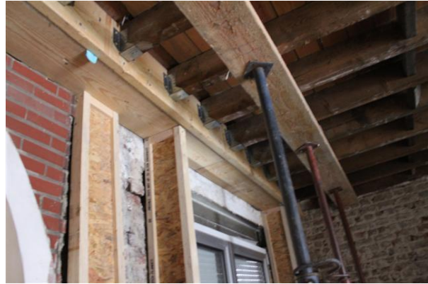
Photo 24 - Mise en place de la poutre recomposée et des supports en FJI (Source : Alexandre O., 2011)
