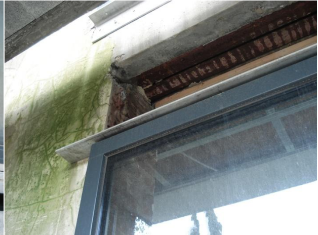
Photo 41 – Cornière supérieure du châssis
