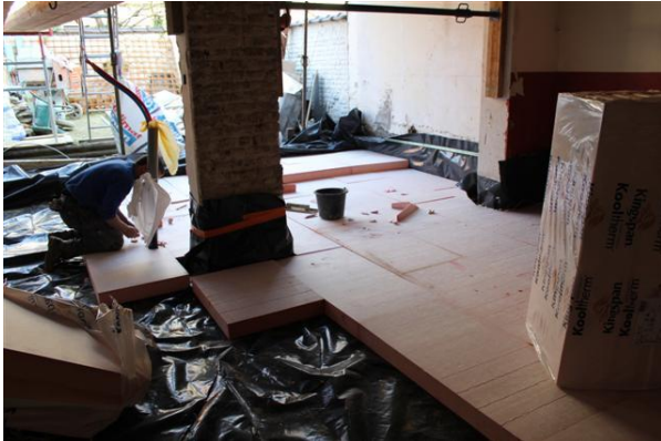
Photo 16 – Mise en place de l'isolation (Source : Alexandre O., 2011)
