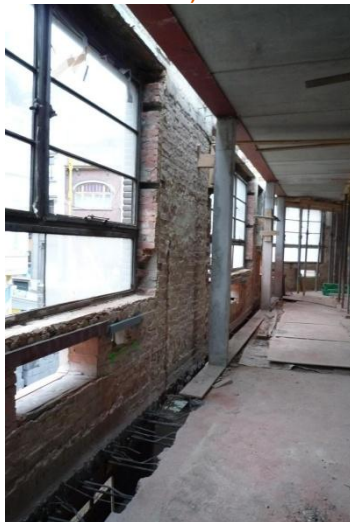
Photo 50 - Mise en œuvre des colonnes en béton armé (Source : Bureau A2M, 2011)
