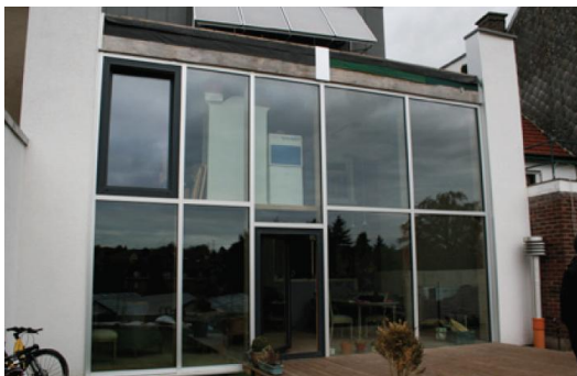
Photo 2 – Façade côté jardin après rénovation
