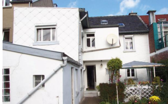
Photo 4 - Façade côté jardin avant rénovation (Source : Bureau FHW, 2007)
