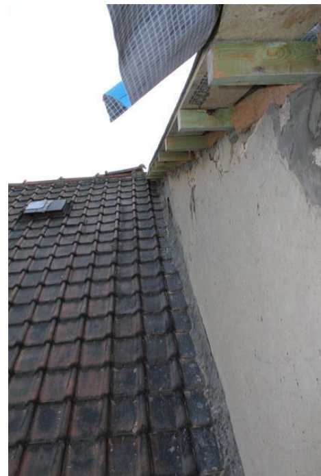
Photo 31 - Structure de la nouvelle charpente (Source : Alexandre O., 2011)
