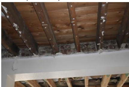
Photo 10 – Plancher en bois sur solive (Source : Alexandre O., 2011)
