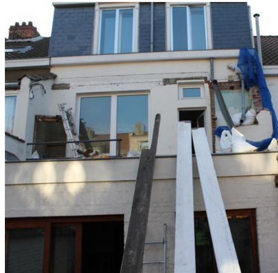
Photo 14 - Façade côté jardin avant rénovation (Source : Alexandre O., 2011)
