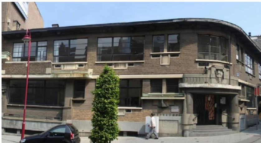
Photo 45 - Façade côté rue avant rénovation (Source : bureau A2M, 2011)
