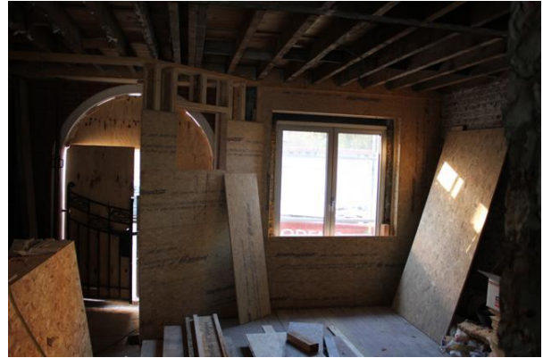
Photo 26 - Contreventement de la façade (Source : Alexandre O., 2011)
