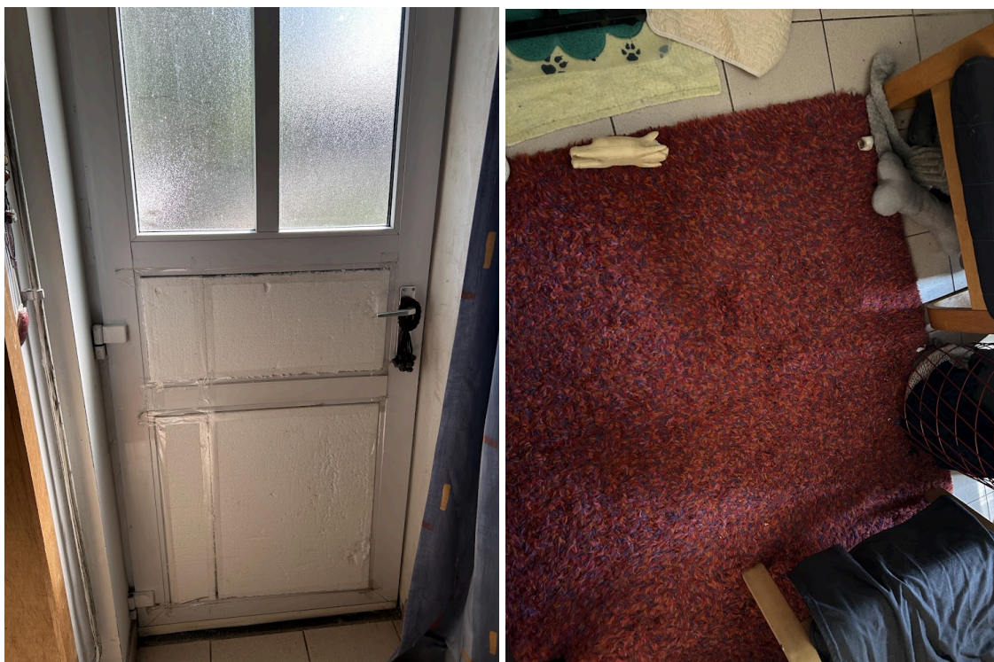
Figure 38 - Photo d'une porte isolée avec du polystyrène. Photo personnelle, ca. 2025.
