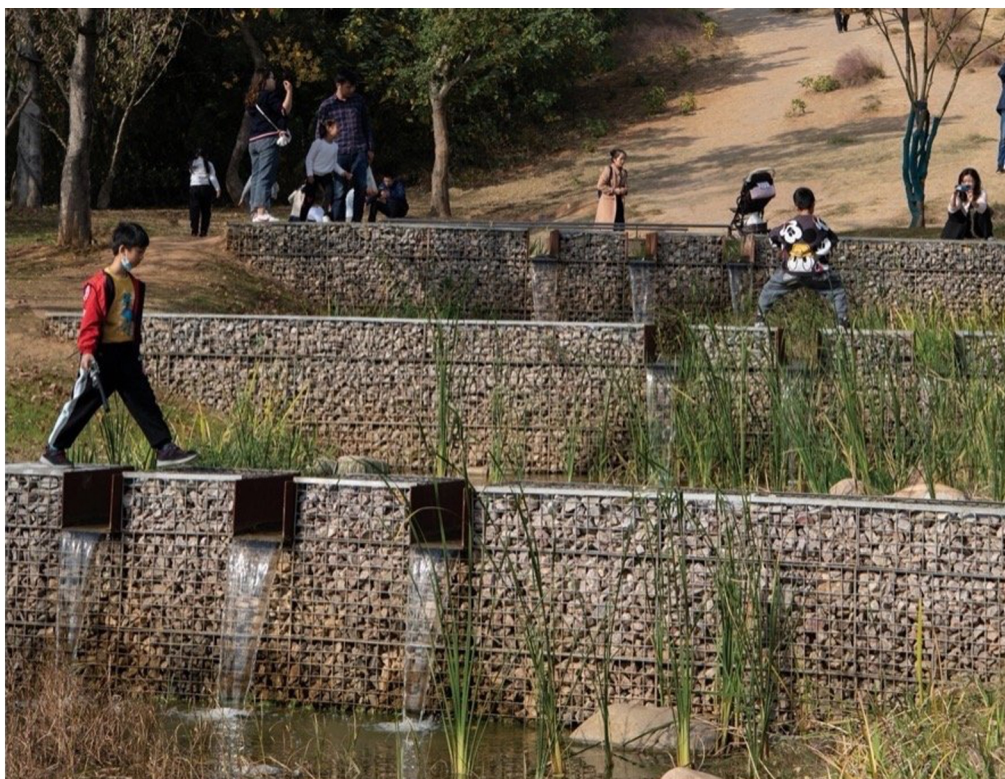
Figure 19: Gestion intégrée de l'eau Schéma de captation et de filtration des eaux pluviales, et dispositif de bassins à gabions. Source : Z+T Studio, Tangshan Quarry Park, via Landezine. Droits réservés, Z+T Studio.
