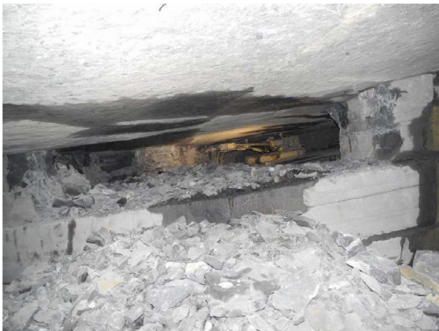
Remblais d'une partie des galeries souterraine Carrière de Golzannes, actuel
