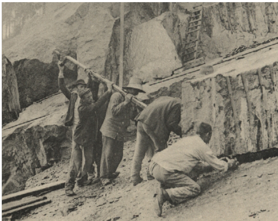
Soulèvement d'un bloc déroché à l'aide de coins en fer enfoncés et de leviers, Mazy archive d'Auvelais donné par Christian Bouchat, archives, Auvelais
