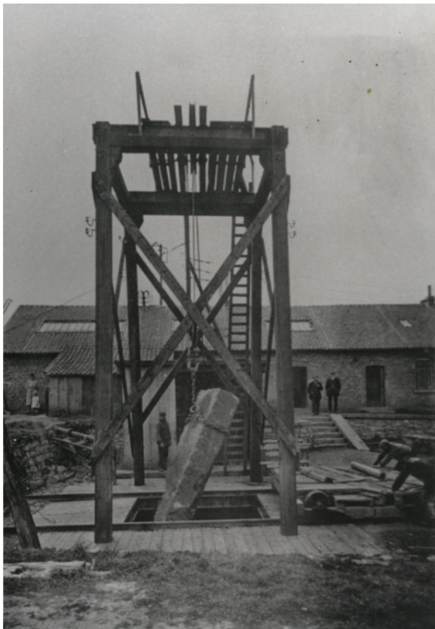
Remonter d'un bloc de marbre avec un treuil Carrière de Golzennes, vers 1929
