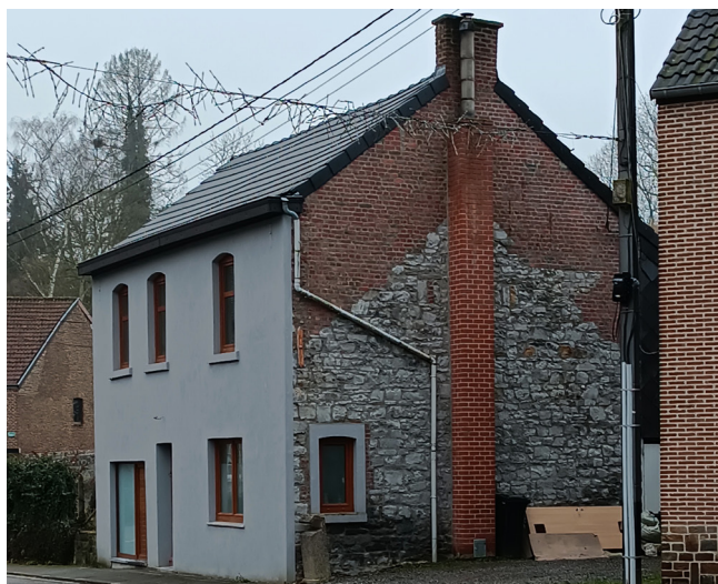
Façade recomposée, briques et moellons, maison du centre d'Onoz Photo de Daniel Djike
