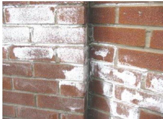
Figure 21 : Efflorescence de sel.
