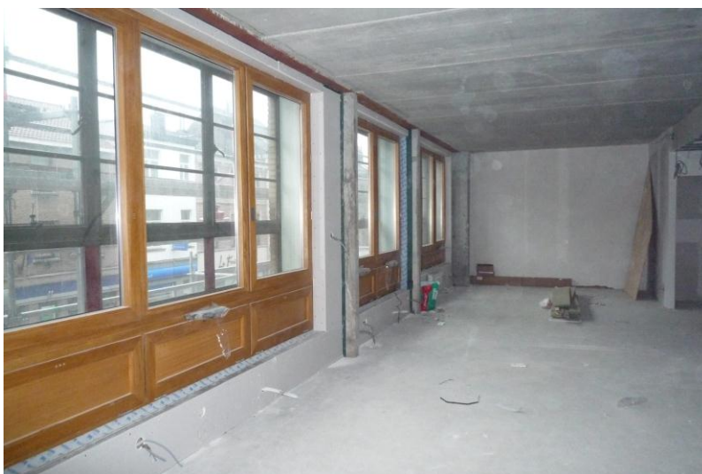
Figure 32 : Photo de l'implantation des doubles châssis. [Willem.2012]
