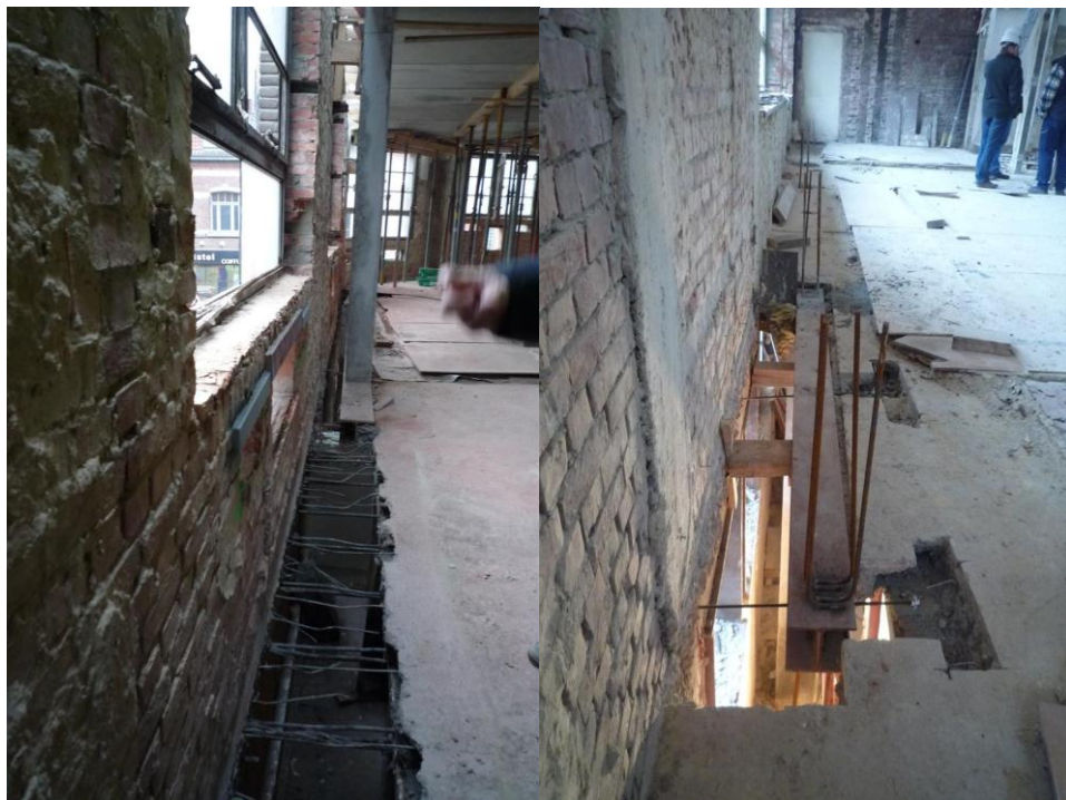
Figure 26 : Saignée réalisée dans la dalle de béton existante & mise en place de la poutre métallique avec barres d'attente pour les colonnes en béton armé futures. [Willem.2012]
