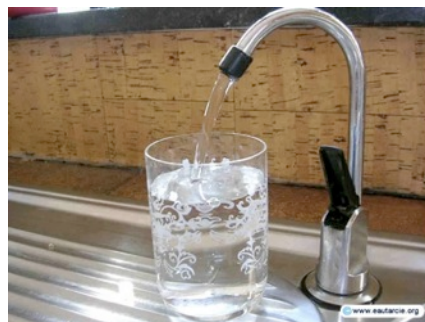
Figure 32: Robinet poussoir - arrivée d'eau potable (source : Orszàgh, 2012)
