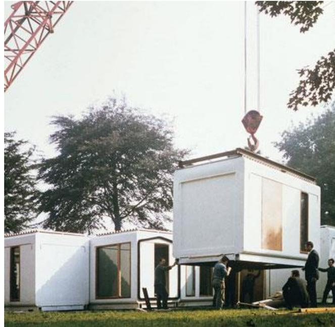
**Figure 42:** cabine SIB-CRAU lors d'un essai de montage
