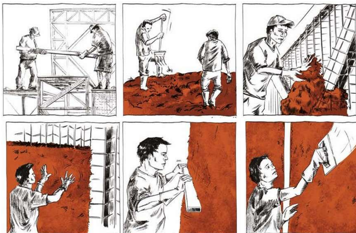
Figure 16 . Procédé de réalisation de mur en Torchis. Crédit : Pauline Sémon (2016)
