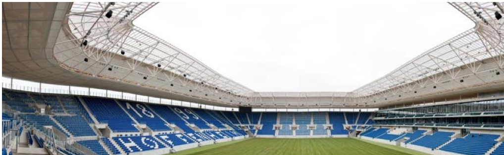
Figure 31: Toiture translucide de la Rhein-Neckar-Arena, réalisée avec des panneaux de polycarbonate (Bayer, 2009)
