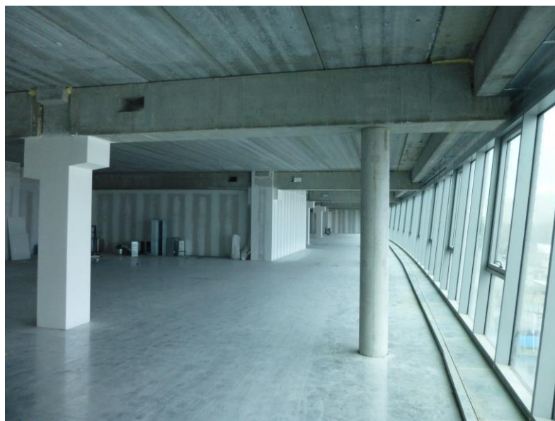
Figure 17 : État dans lequel sont livrés les espaces aux locataires
