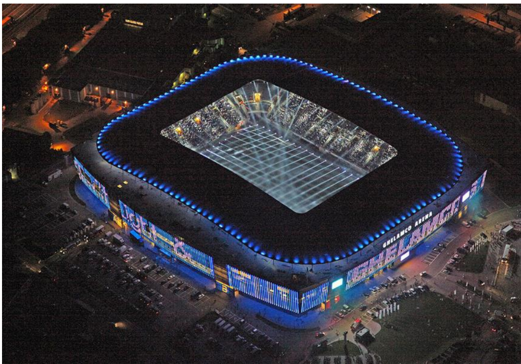
Figure 21 : Eclairage nocturne de la façade lors de l'inauguration, le 17 juillet 2013, (source : http://www.ourfuturestartshere.be/pictures , 2013)
