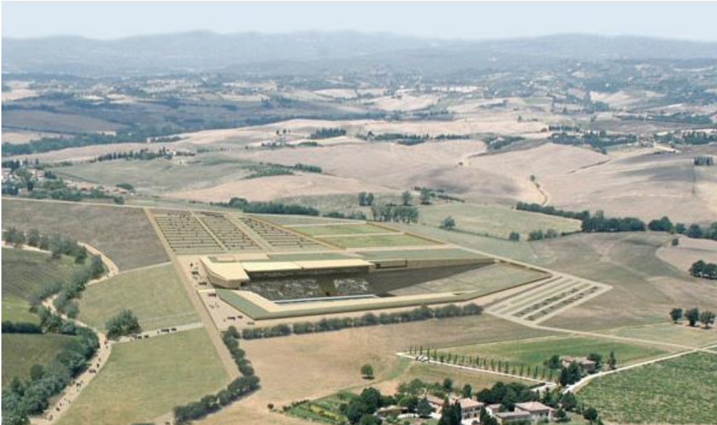
Figure 41: Vue de l'intégration dans le site du projet de nouveau stade communal à Siena ( http://www.lotti-pavarani.com )
