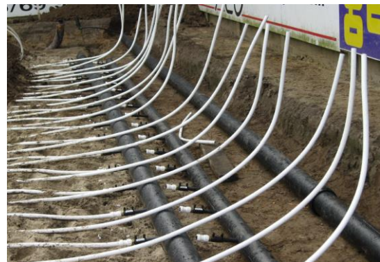
Figure 29: Illustration des tuyaux utilisés dans un système de chauffage de pelouse hydraulique
