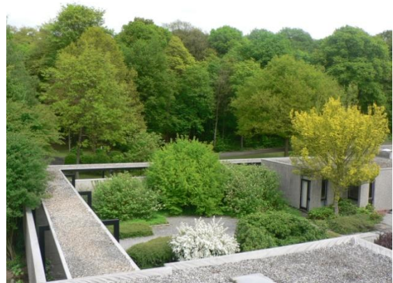
Figure 104: Abbaye de Soleilmont, coursive des hôtes et jardin intérieur
