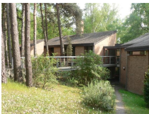
Figure 85 : Monastère de Clerlande, articulation de l'ancienne maison universitaire et de la nouvelle aile de l'hôtellerie
