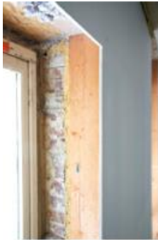
Figure 22 - Isolation par l'intérieur (Glavie)
