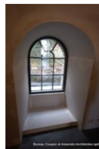
Figure 74 - Châssis métallique (Bureau Coupez et Associés, 2011)
