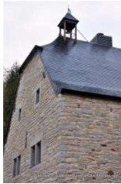
Figure 69 – Toiture restaurée (Bureau Coupez et Associés, 2011)
