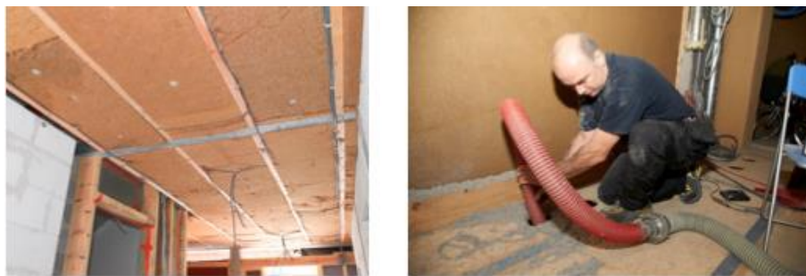
Figure 19 - Isolation d'un plancher inférieur (a) par le bas - (b) par le haut (Glavie)
