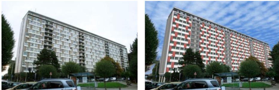
Figure 80 - Façade Ouest (a) avant rénovation - (b) après rénovation (AW Architectes, 2013)
