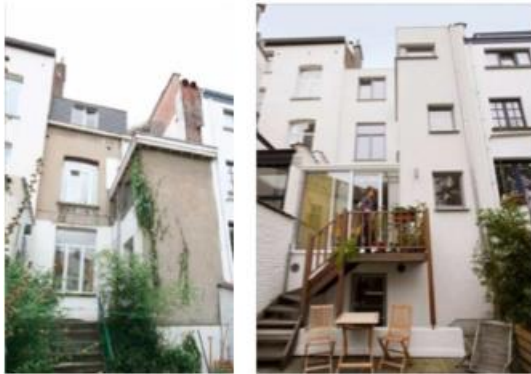
Figure 48 - Façade arrière avant et après rénovation (Closson, et al., 2013)
