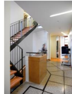
Figure 97 - Maintien du revêtement de sol en granito d'origine (A2M, 2010)
