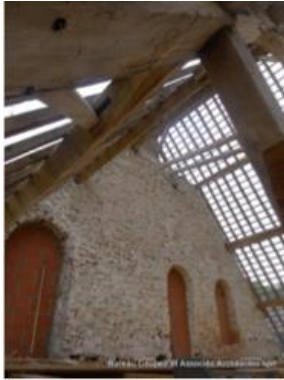
Figure 68 - Rénovation de la toiture (Bureau Coupez et Associés, 2011)
