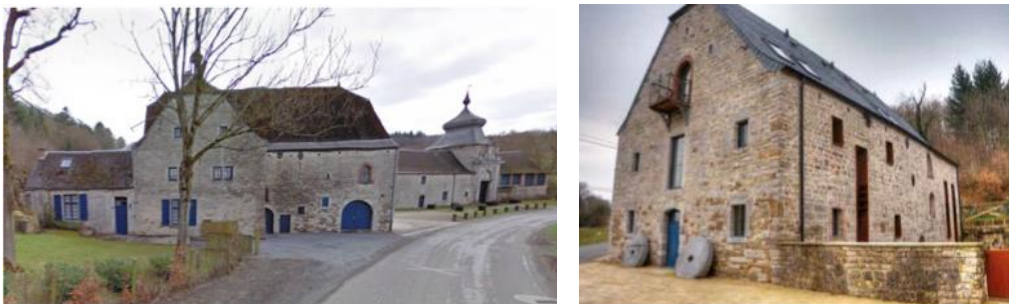
Figure 62 - Bâtiment (a) avant rénovation - (b) après rénovation (Bureau Coupez et Associés, 2011)
