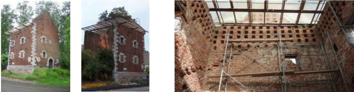
Figure 125 – (a) Façades nord-ouest/sud-ouest et sud-ouest/sud-est – (b) Intérieur (Evrard, 2011)
