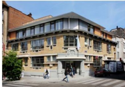
Figure 109 - Façades Sud et Ouest (A2M, 2010)
