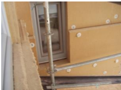
Figure 52 - Isolation de l'annexe (Marc Van der Stricht Architecte, 2010)
