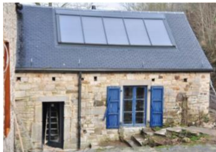
Figure 77 - Toiture de l'annexe (Bureau Coupez et Associés, 2011)
