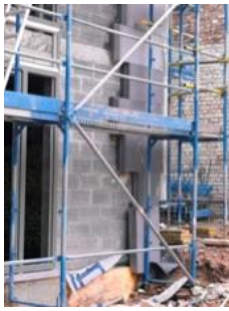
Figure 21 - Isolation par l'extérieur (Glavie)
