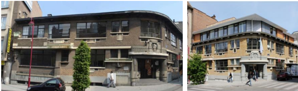
Figure 95 - Façade Sud(a) avant rénovation - (b) après rénovation (A2M, 2010)
