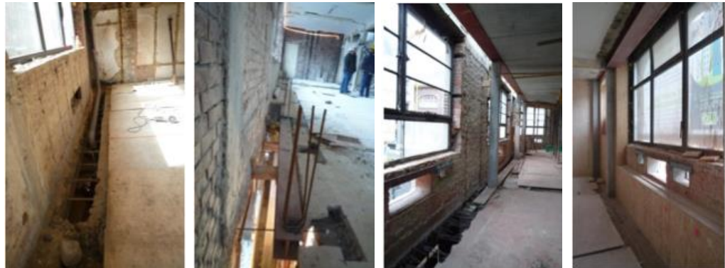
Figure 105 - (a) Découpe de la dalle – (b) Encoche de la dalle – (c) Mise en place des colonnes en béton armé – (d) Mise en place de l'ossature bois (A2M, 2010)
