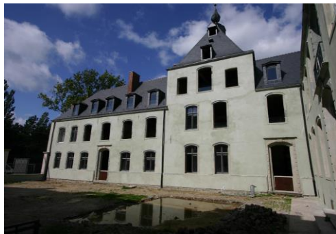
Figure 138 - Château de Clabecq (R.E.D, 2013)
