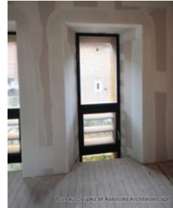
Figure 76 - Nouvelles baies (Bureau Coupez et Associés, 2011)
