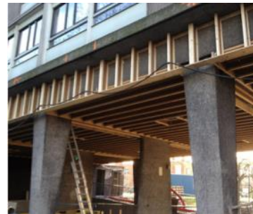
Figure 93 - Isolation du plancher (AW Architectes, 2013)
