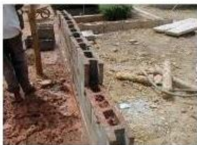
Mur à l'élévation
