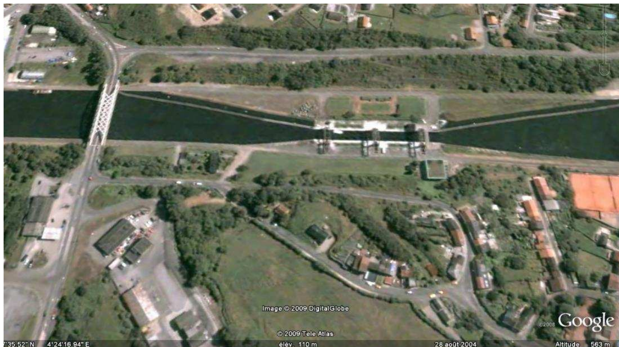
Figure I-VI : Site actuel à Gosselies (source : Google Earth)
