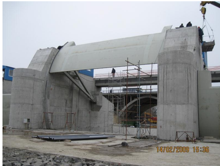
Figure 27 : Vanne segment en position ouverte lors de la construction ( http://www.vaphydro.bg )
