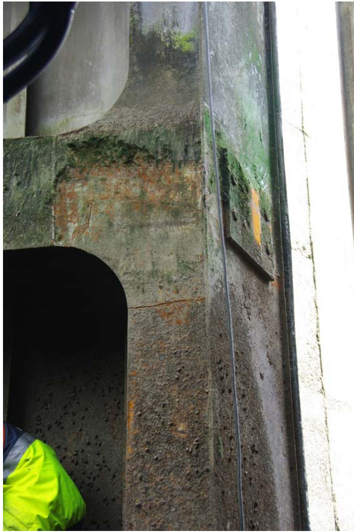
FIGURE 4.2 – Fissure dans une semelle d'un poteau busqué de la porte aval [Vercruysse]
