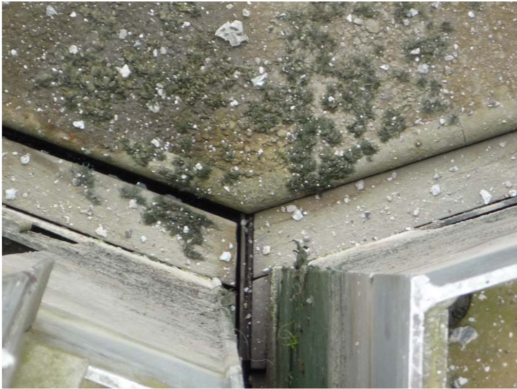
FIGURE 5.73 – Vue de la base du poteau busqué
