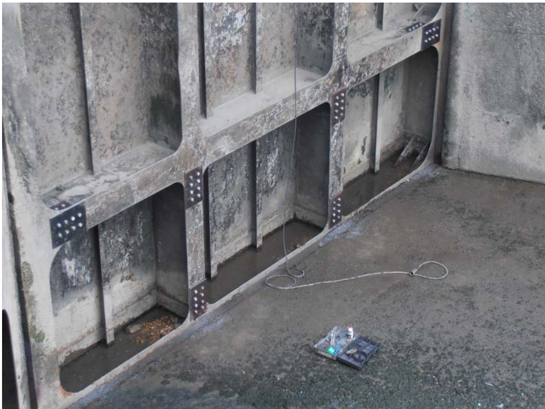
FIGURE 4.11 – Renforcement de la porte amont en 2011 [Vercruysse]
