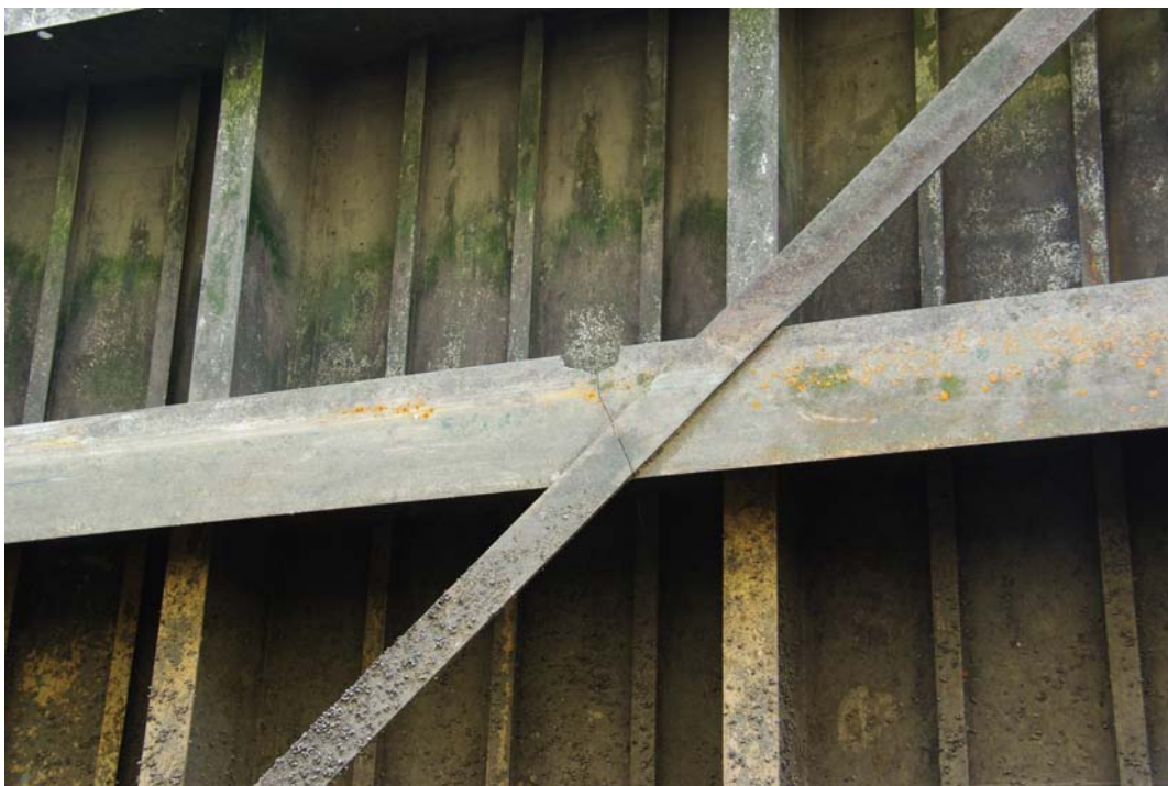
FIGURE 4.4 – Fissure dans une semelle d'une traverse de la porte aval [Vercruysse]
