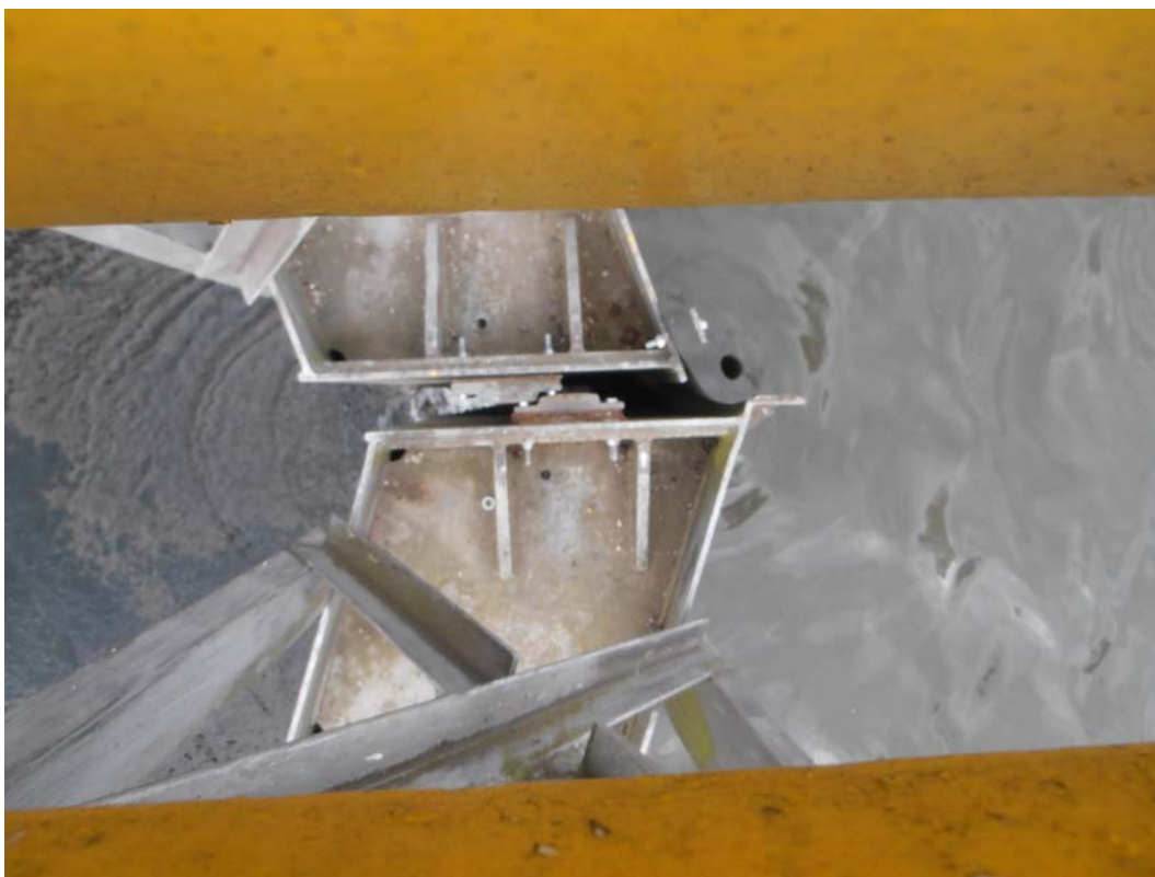
FIGURE 4.7 – Non alignement des heurtoirs sur les vantaux de la porte amont [Vercruysse]
