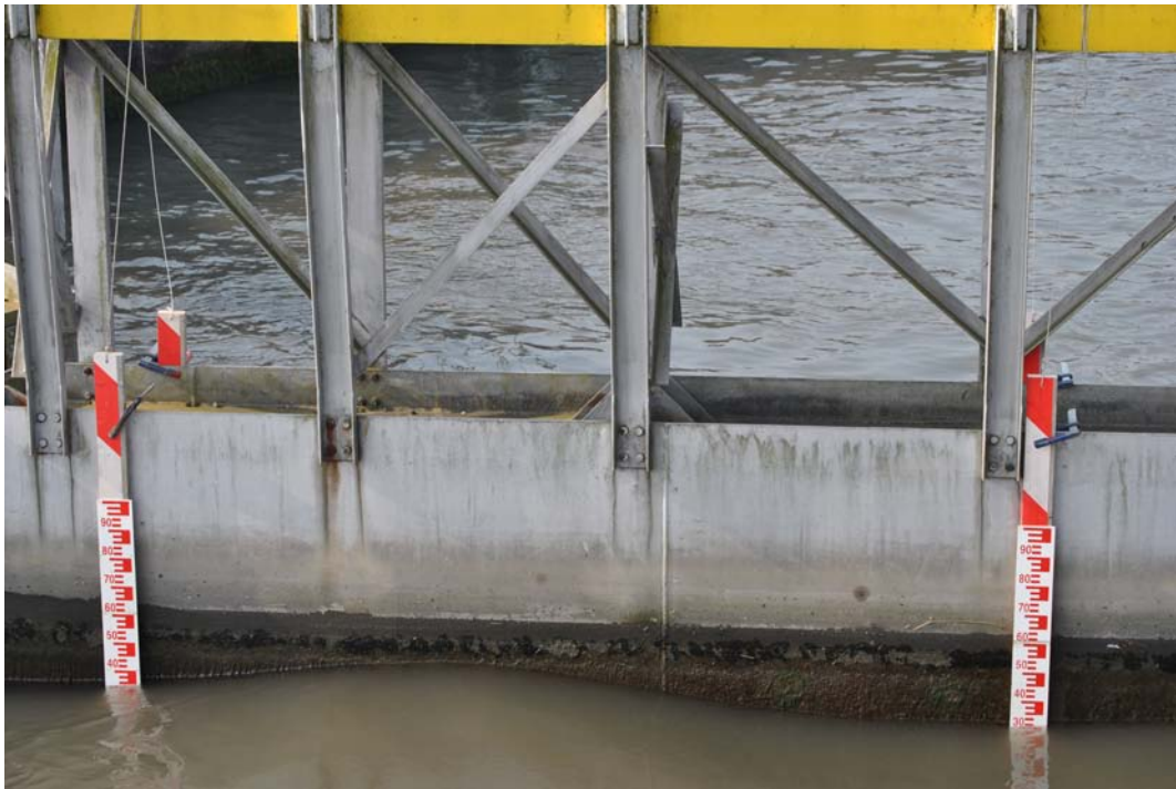
FIGURE 5.71 – Échelles graduées du côté du bordé
