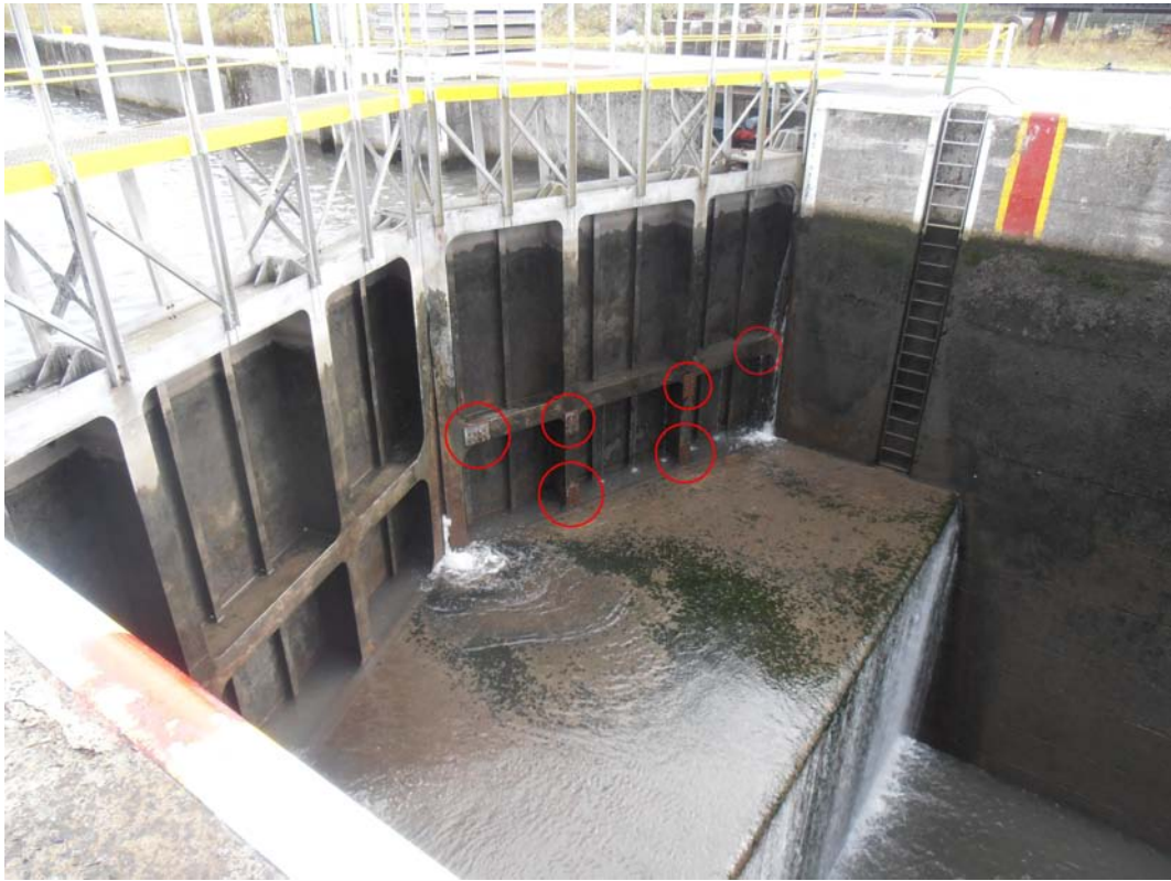
FIGURE 4.10 – Renforcement de la porte amont en 2011 (vue générale) [Vercruysse]
