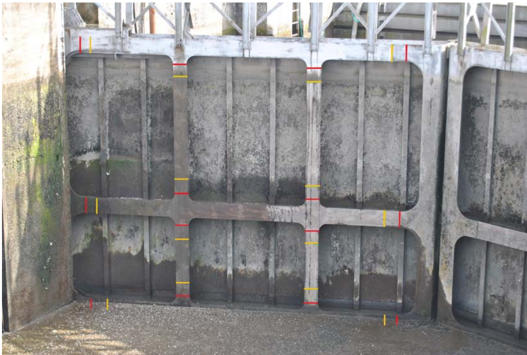
FIGURE 6.13 – Localisation des anciennes soudures (en rouge) et des nouvelles (en jaune) [Vercruysse]
