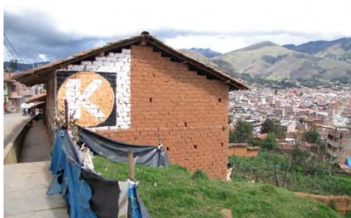
Figure 195 : Maisons en adobe sur terrain escarpé.
