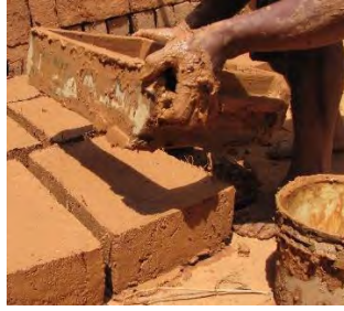
Figure 161 : Etapes de fabrication d'une brique d'adobe.
