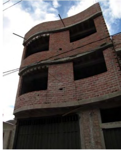
Figure 59 : Importance des baies permises par le principe de la façade libre grâce au système à base de poteaux-poutres.
