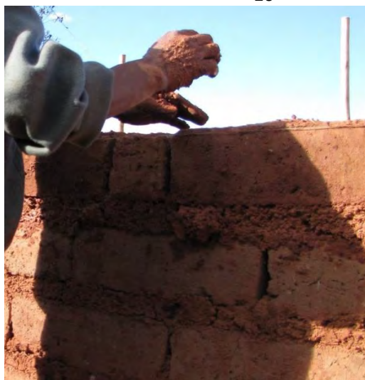
Figure 173 : Quelques étapes de la construction d'une maison en adobe.
