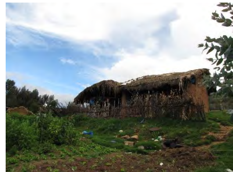
Figure 77 : façade avant de la maison 1 étudiée.
