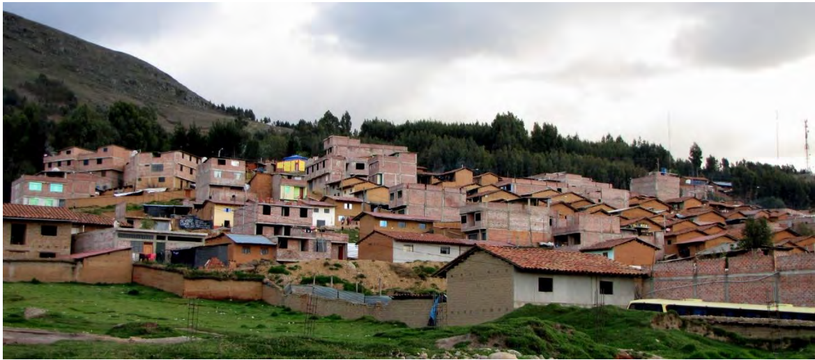
Figure 60 : Photo montrant l'émergence de plus en plus de constructions en poteaux-poutres.
