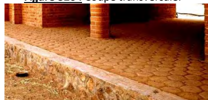
Figure 327 : sol en terre comprimée.
