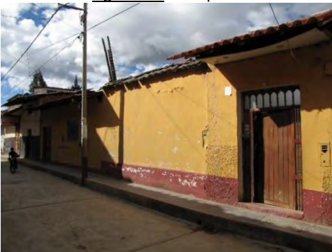
Figure 97 : Façade discrète sur rue.
