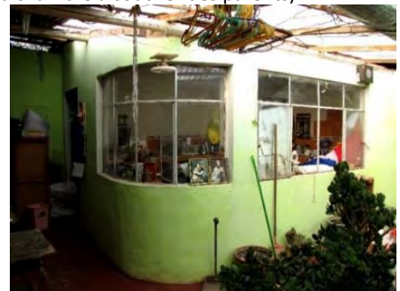
Figure 96 : Cuisine en béton et briques de la partie privative.
