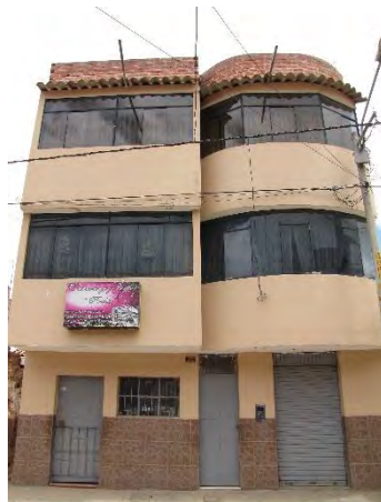
Figure 220 : Façade de l'immeuble.
