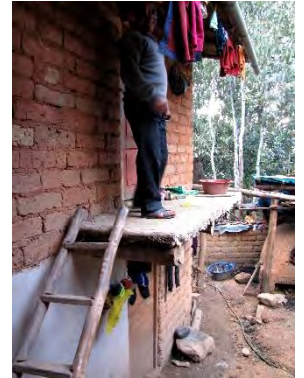
Figure 201 : Accès à la cuisine
