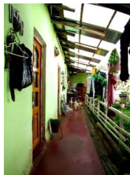
Figure 113 : Galerie du second patio
