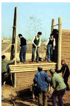
Figure 72 : Technique du pisé en Chine
