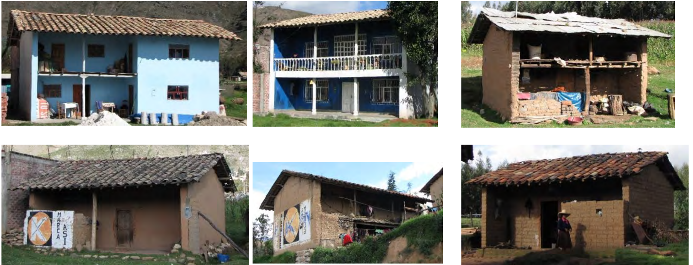
Figure 39: Façades d'habitations localisées en zone rurale.
