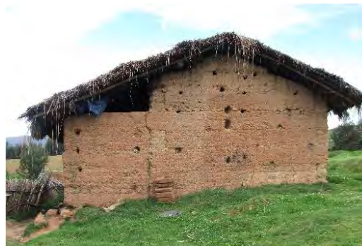
Figure 84 : Pignon de la maison montrant l'importance des trous dont le diamètre s'est élargi au fur et à mesure des années.
