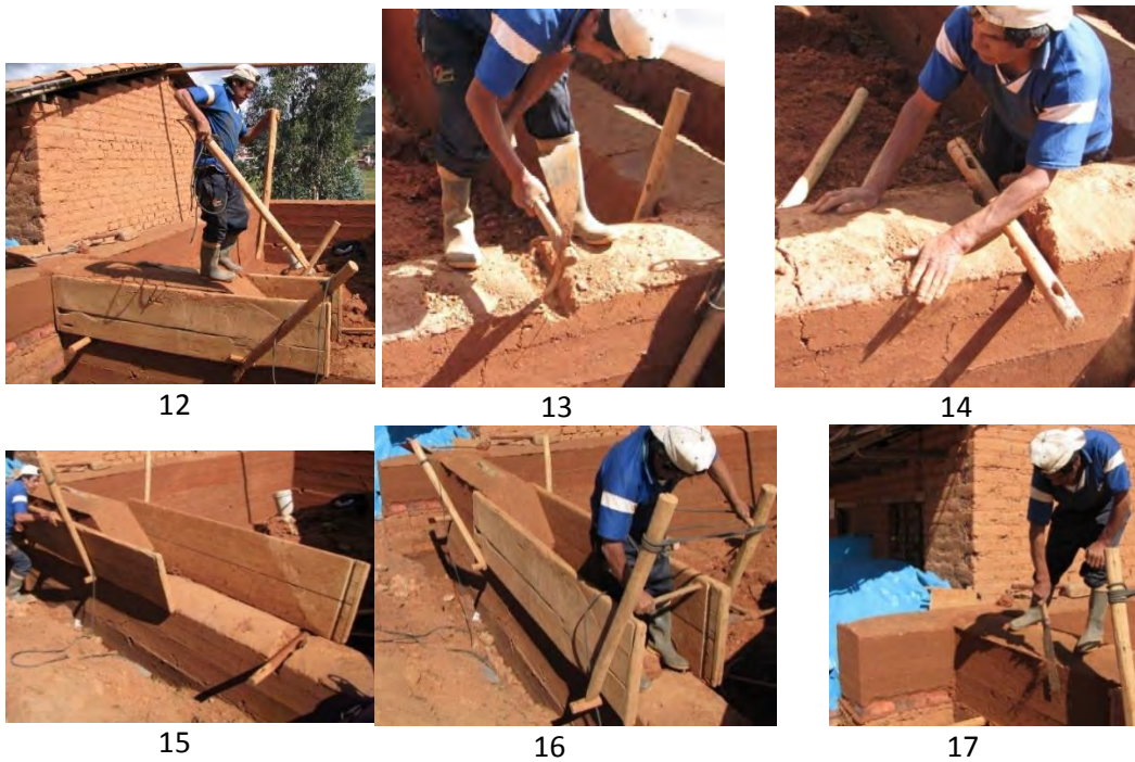
Figure 74 : Quelques étapes de la construction d'une maison en pisé.
