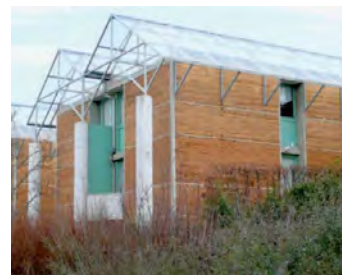
Figure 314 : Vue des deux édifices du bloc F
