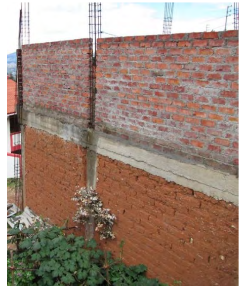
Figure 58 : Maison utilisant divers types de matériaux.
