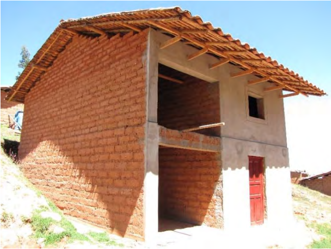
Figure 56 : Maison en adobe
