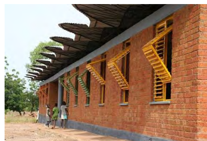
Figure 323 : Vue de l'école primaire au village de Gando
