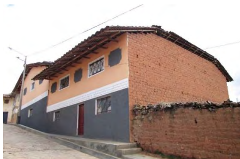
Figure 263 : Bloc en adobe
