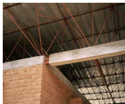
Figure 325 : Poutres en béton armé.
