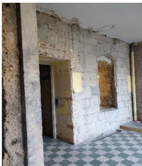
Figure 44 : Façade médiévale avec « baie du XIVème siècle ajourant la façade nord primitive au premier étage » dissimulée par l'extension pour créer une salle de bain dans le bâtiment n°9. Photographie personnelle : © M. Bauvir (le 22 avril 2024).
