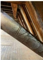
Trace de marque d'assemblage en chiffres romains (O. Noël, 2024)
