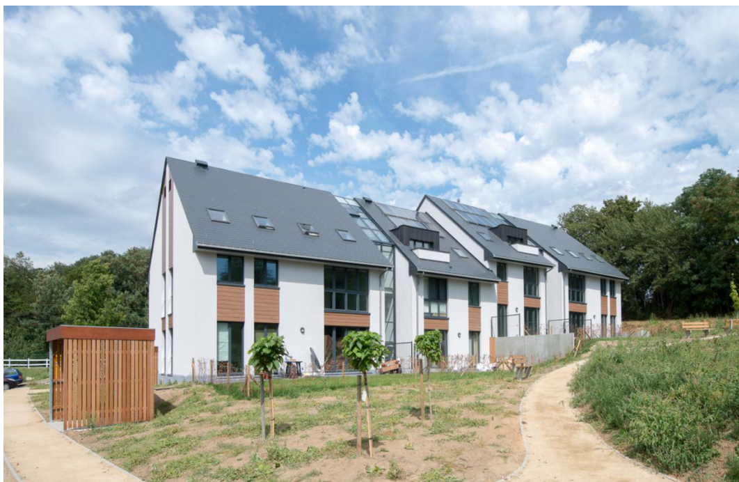
Figure 3 : Bloc A façades ouest-sud et sud-est (SLRB, 2015)
