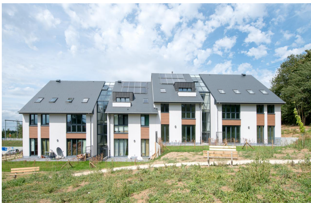
Figure 4 : Bloc A façade sud-est (SLRB, 2015)
