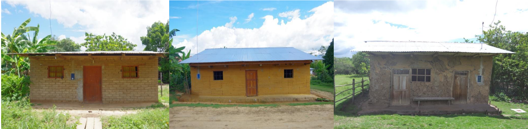
▲ Ci-dessus : méthodes constructives traditionnelles à partir de terre crue. (De gauche à droite : adobe, tapial et quincha). Crédits photos : Pierre LEGNIERE.
