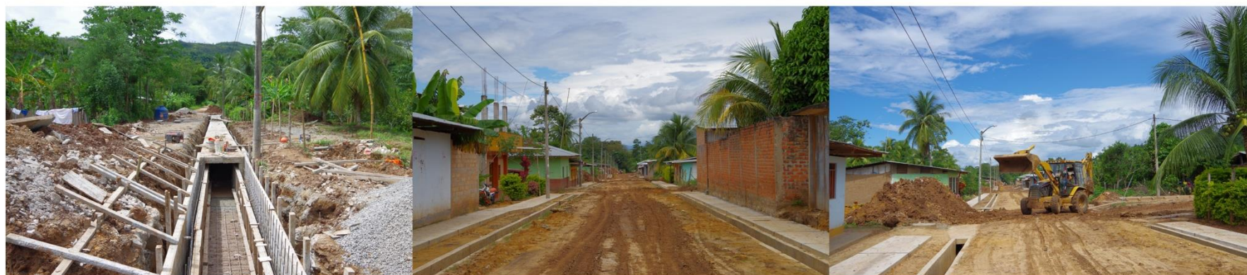
100 ▲ Ci-dessous : Aperçu des travaux d'assainissement et de drainage des eaux pluviales à Rumizapa . Crédits photos : Pierre LEGNIERE
