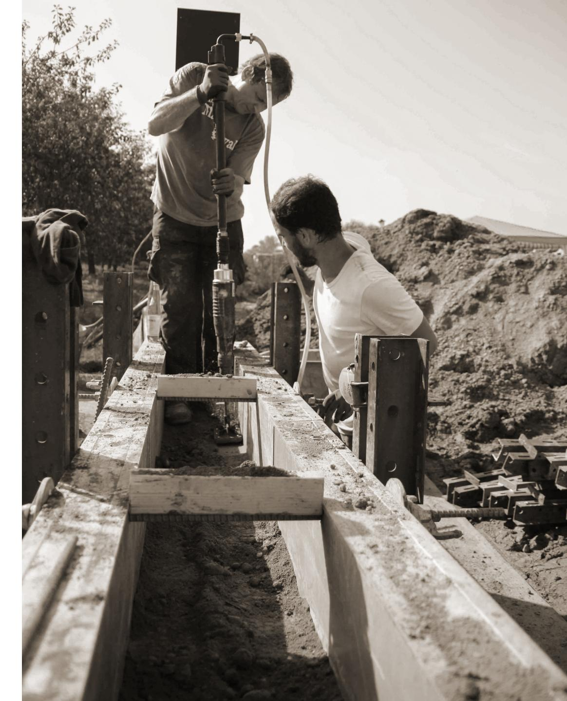
> **Figure 44 :** Réalisation d'un mur en terre compactée, Haaltert (Flandre-Orientale), 2018. Be Circular. (2018). Valorisation des terres d'excavation par BC Materials [photographie]. Circulareconomy.brussels. <https://www.circulareconomy.brussels/bc-materials-bc-materials-de-la-terre-dexcavation-au-materiel-de-construction/>
