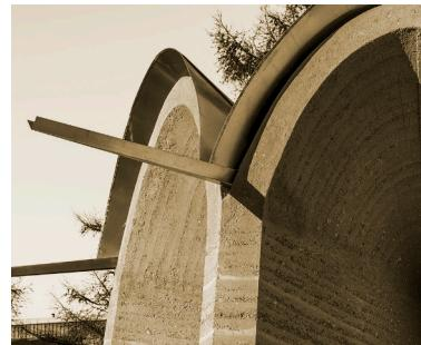
**Figure 9 :** Protection de l'eau d'une structure en pisé préfabriquée, réalisée par des étudiants - Faculté d'architecture, Zurich, 2014.
