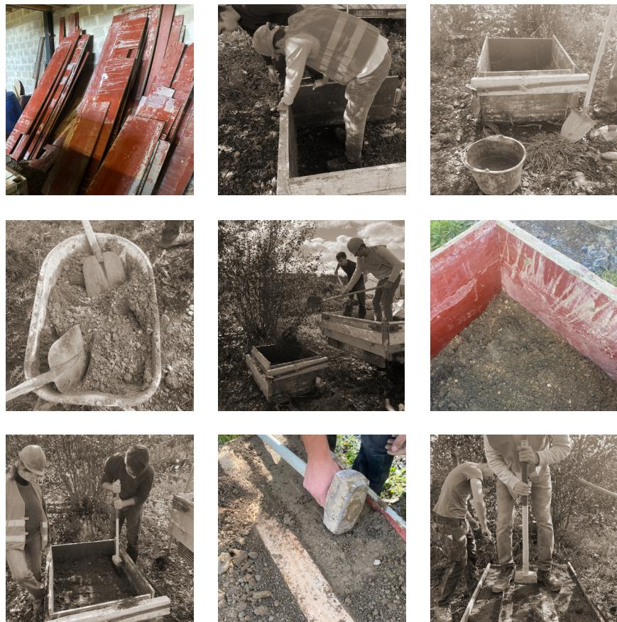
^ **Figure 85 :** Montage photographique : réalisation d'une assise en pisé, échelle 1/1. Réalisation du coffrage et ramassage de la terre. Photographies : Legros, B., 2024.
