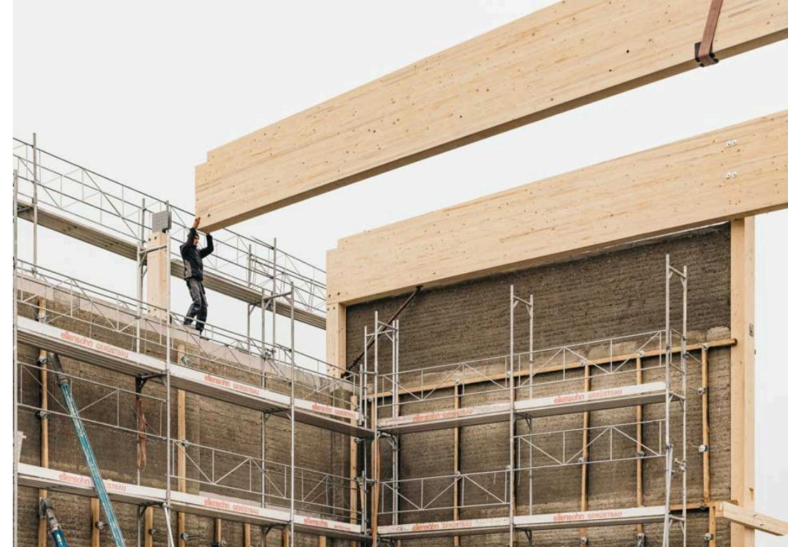
> Figure 71 : Construction du nouveau siège social de Lehm Ton Erde Baukunst GmbH. Structure hybride en bois et pisé, Autriche, 2024. Mackowitz, H. (2024, 2 février). Werkhalle Erden - Konstruktion in Holz und Lehm [photographie]. Baubiologie Magazin. <https://bit.ly/3YwlF2g>
