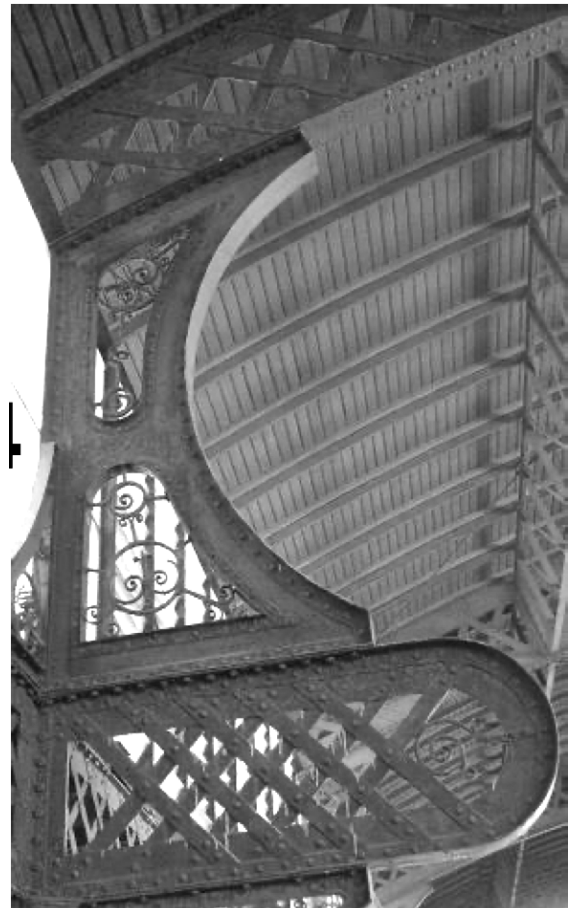
Fig. 10 Grande console entre poutre primaire et secondaire
