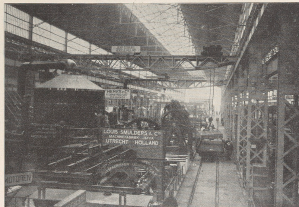
PONTS ROULANTS DE LA GALERIE DES MACHINES. — DÉCHARGEMENT D'UNE GROSSE PIÈCE.
