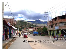
Photo prise au niveau de la section H2
