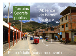
Photo prise au niveau de la section H3
