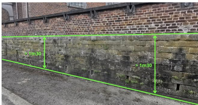
Figure 4. Mur constitué de matériaux hétérogènes. La portion sélectionnée, en contact avec le sol, doit être d'une hauteur de 1m30 et d'une largeur de 1m.
