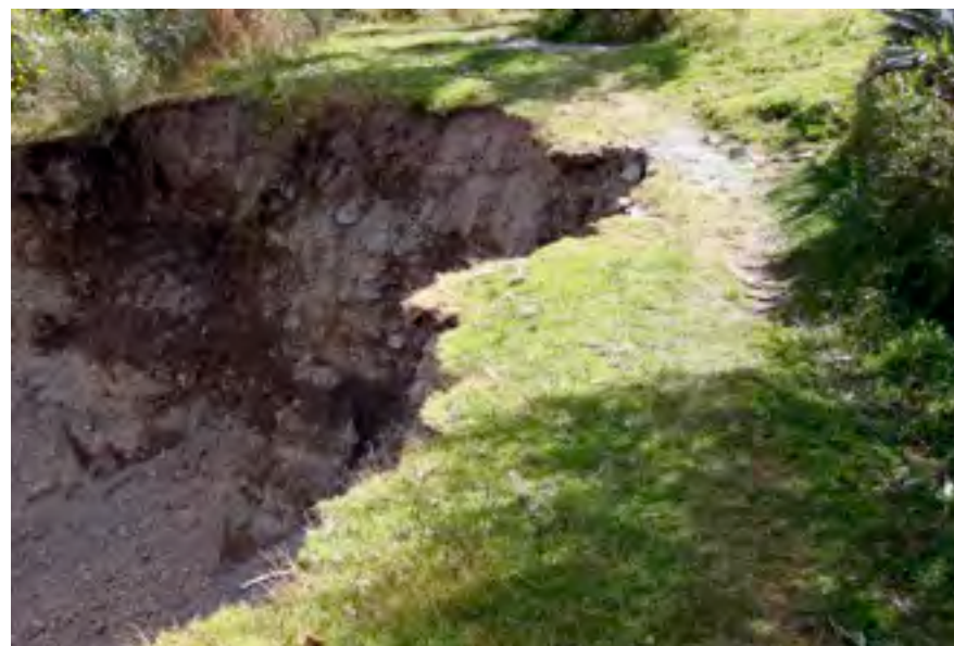
11-3, glissements de terrain
