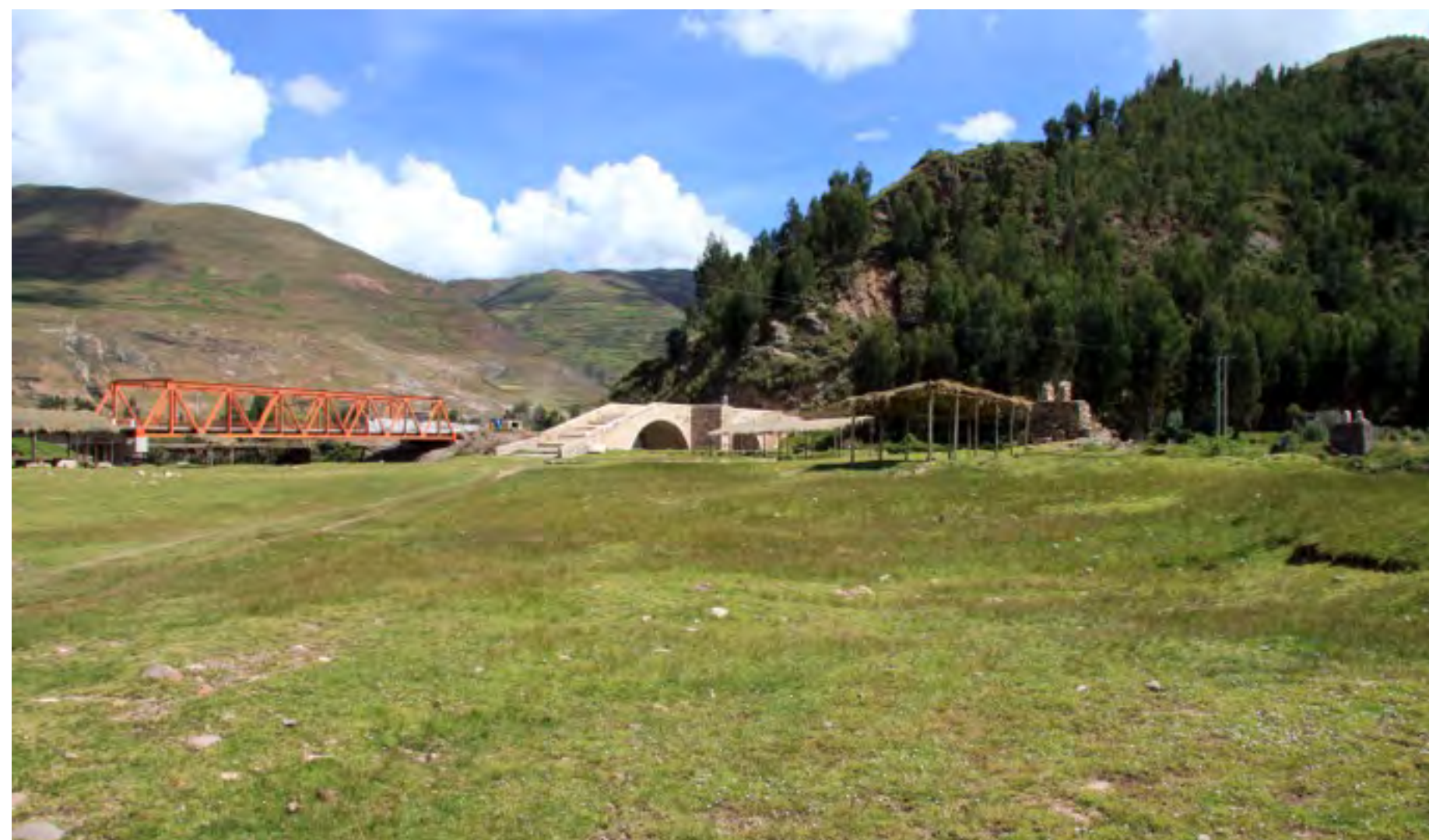
8-1, Combapata, sens Checacupe, les trois ponts, de gauche à droite : pont contemporain, pont colonial, pont inca
