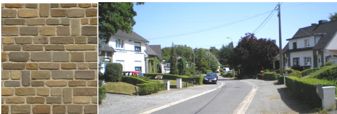
Figure 18 : Habitations du 3 e chantier rue de Peupliers
