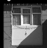
Figure 3, 4, 5 : Fenêtres traditionnelles : Bas-relief, linteau et encadrement
