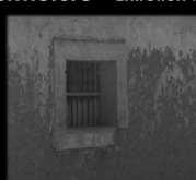
Figure 3, 4, 5 : Fenêtres traditionnelles : Bas-relief, linteau et encadrement
