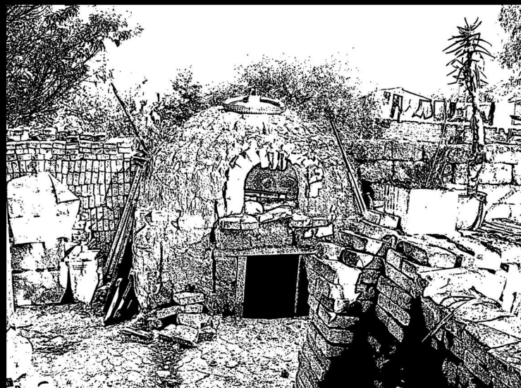
Figure 4 : Ancien four à pain
