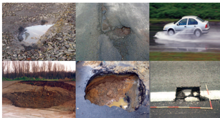
FIGURE 10 – Dégradations liées à la présence de l'eau (CRR, 2014)
