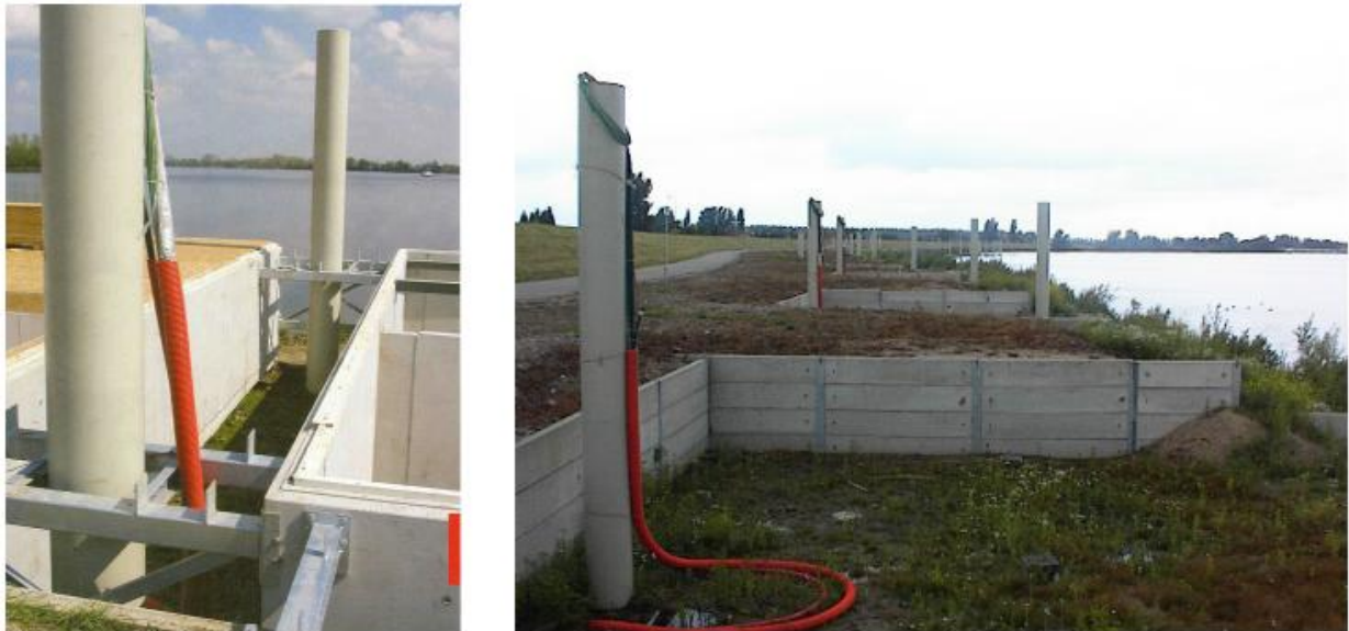
Figure 35: Photographies des pieux coulissants (Factor Architecten, Pays bas)
