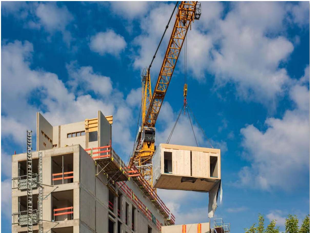
Figure 16: un module en cours d'assemblage sur un chantier (The Code Authority® (UL) – construction modulaire levée par grue)
