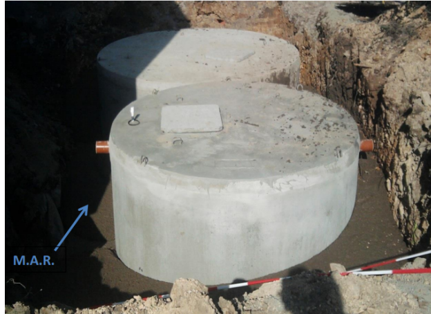
FIGURE 3 – Remblayage de la fouille autour d’une citerne à l’aide de MAR (CSTC, CRR, SPW, FEREDCO. 2012)
