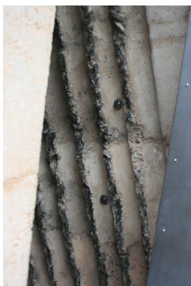
fig. 77 – matériaux intérieurs, Bruder Klaus feldkapelle
