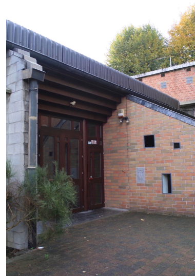
fig. 76 – matériaux extérieurs, église Saint-François de Sales du Laveu
