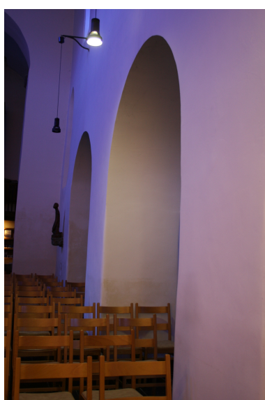
fig. 78 – matériaux intérieurs, église Saint-Etienne de Waha
