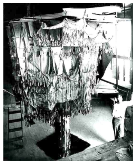
Figure 6: Maquette funiculaire de Gaudi (Wendland, 2000).
